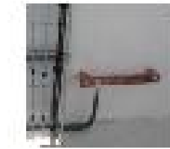
Figura 1.82: Barra Principal de Tierra
