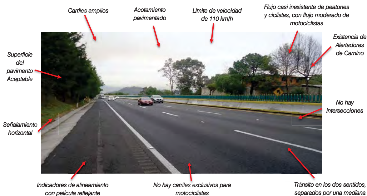
Figura 3.5 | Forma de calificación para la infraestructura vial, en la Autopista México-Cuernavaca
