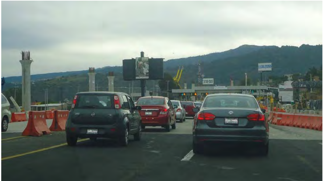
Figura 4.4 | Caseta de cobro de "Tlalpan" en el km 23+360 cuerpo A. Se puede observar las barreras tipo New Jersey temporales y de lado izquierdo las pilas donde será montado el Viaducto.
