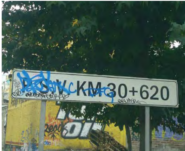
Figura 4.7 | P.S.V. KM 30+620, se encuentra vandalizado y la visibilidad del señalamiento es mala.
