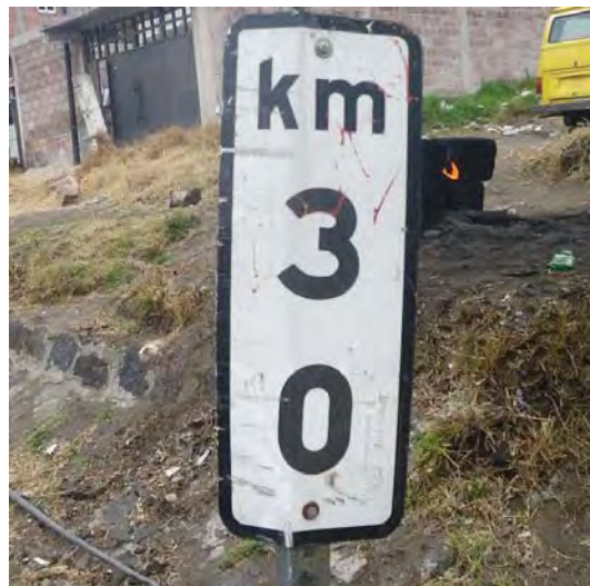
Figura 4.6 | Kilómetro 30+000, no cumple con la Normativa SCT, porque para este caso se requiere que contenga la ruta, además se encuentra en mal estado.
