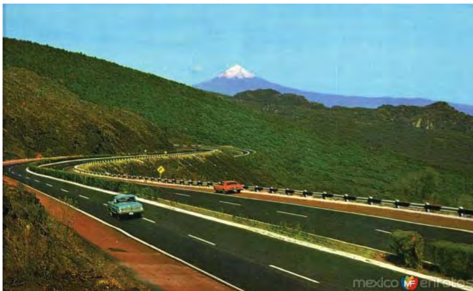
Figura 2.1 | Autopista México - Cuernavaca a los inicios de su operación (Fuente: www.mexicoenfotos.com )
