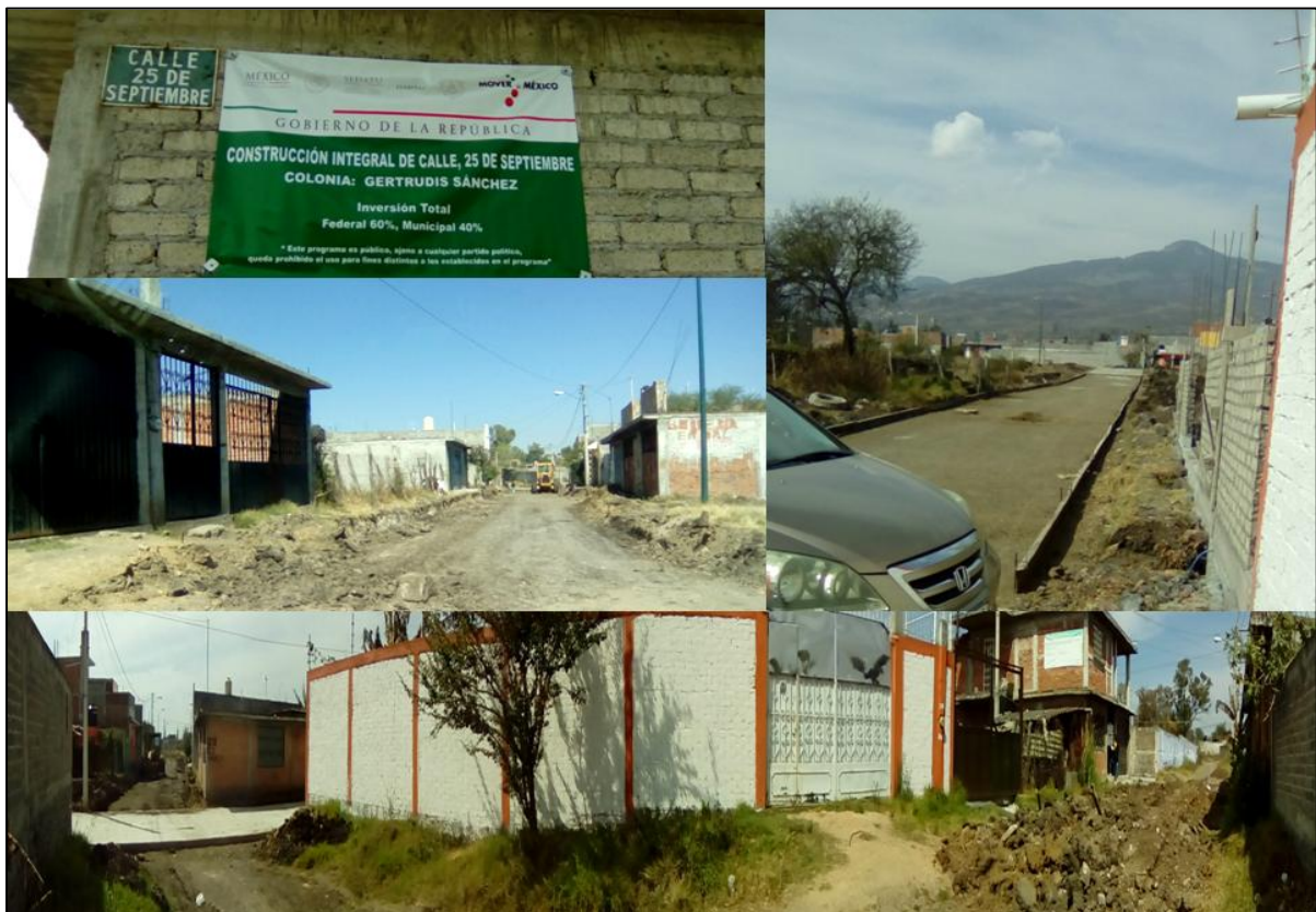
Figura 4.8 Pavimentación de calles en Gertrudis Sánchez Etapa IV. Fuente: Fotografías propias
