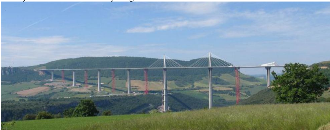
Figura 2.8. Viaducto de Millau, construcción mediante empuje
