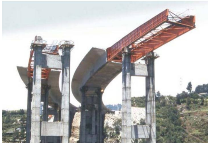
Figura 2.11. Puente empujado y nariz de lanzamiento
