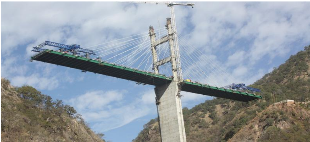
Figura 2.7. Construcción en doble voladizo, puente el Carrizo
