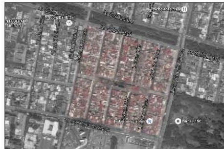
Foto aérea del polígono del fraccionamiento. Fuente: Inventario Nacional de Viviendas: 2015 www.inegi.org.mx
