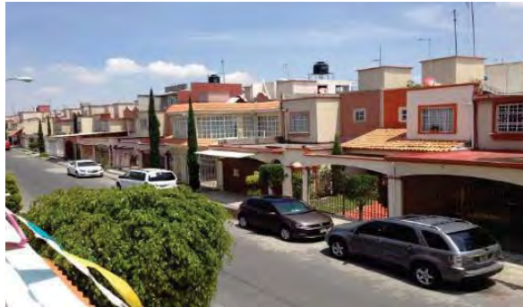
Imagen 49. Viviendas del Fraccionamiento Las Américas
