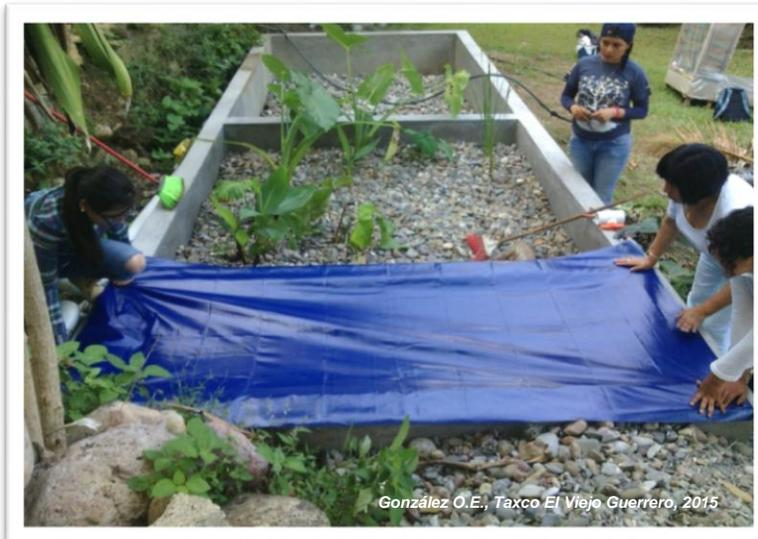
Se cubrió provisionalmente el sedimentador con una lona de vinil, esto para monitorear el humedal artificial mientras se establece y madura el sistema, posteriormente el diseño contempla cubrir esa área, con tapa de cemento.
