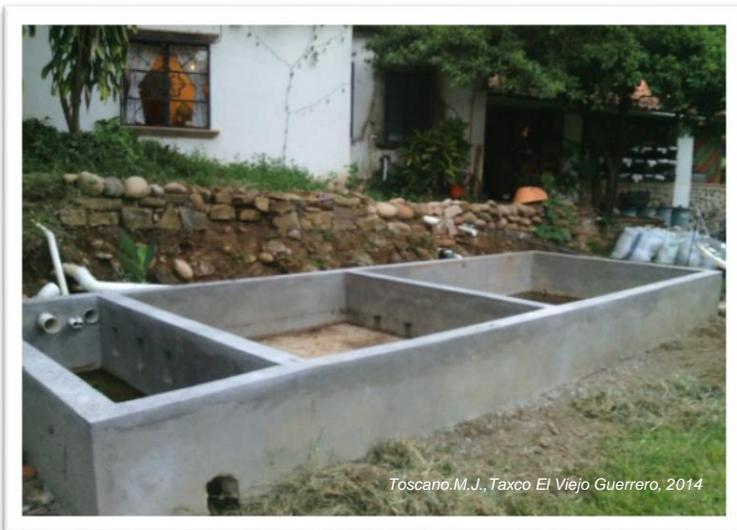
La imagen muestra la estructura del diseño (sedimentador y los dos módulos), además de las conexiones con los tubos de descarga.
