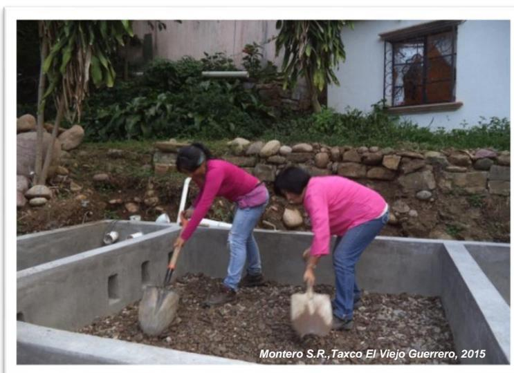
Se rellenó el primer módulo con el sustrato seleccionado, el cual se dispersó de manera uniforme para posteriormente introducir la vegetación.
