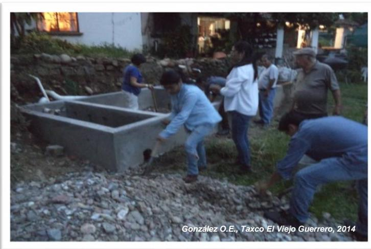
Se colocó el sustrato dentro del sistema, este tipo de material presenta las características físicas y químicas, así como el diámetro necesario para llevar a cabo los procesos dentro del humedal artificial.
