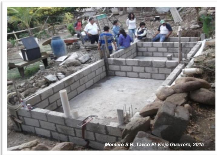
Se procedió a la construcción del humedal artificial, por lo que se contrató a personal para establecer la colocación del tabicón, impermeabilizante y el aplanado de la estructura del sistema.
