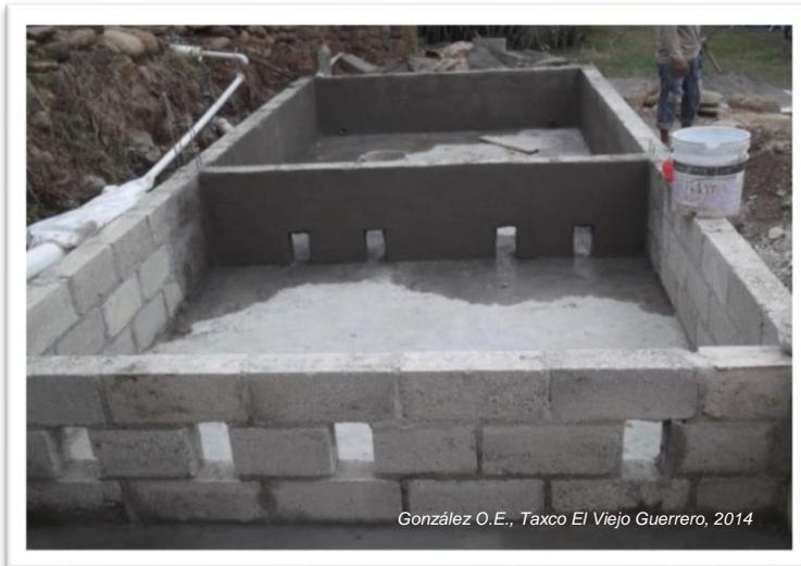
Para el diseño se consideraron cuatro aberturas entre el sedimentador y el primer módulo, otras cuatro aberturas entre el módulo uno y módulo dos, esto con el fin de regular la fluidez del líquido dentro del sistema. En el sedimentador se colocó una llave para descargar los lodos generados producto de la mineralización de la materia orgánica.
