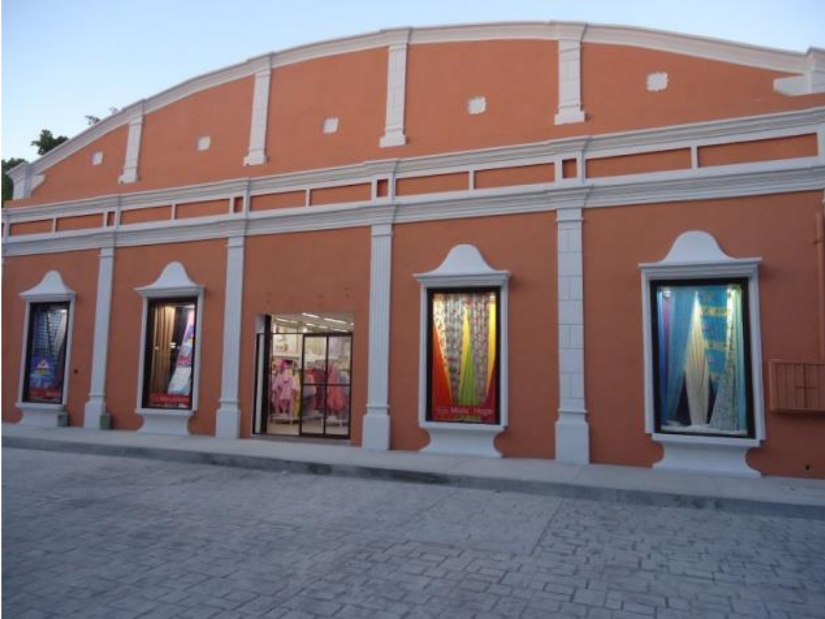
Imagen 23: Bodega o cobertizo industrial con elementos arquitectónicos de orden neoclásico mal integrados a la reciente construcción. 41
