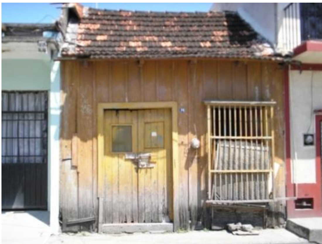
Imagen 19: Edificios en deterioro construidos en la calle 22 con materiales rústicos y teja mecánica. 35
