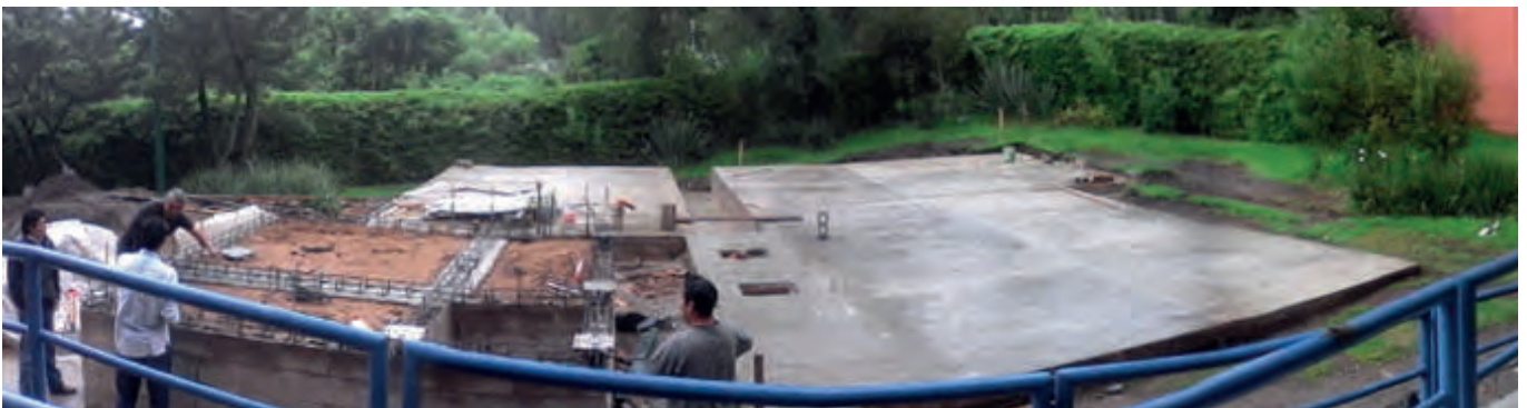
plataformas de cimentación en proceso constructivo
