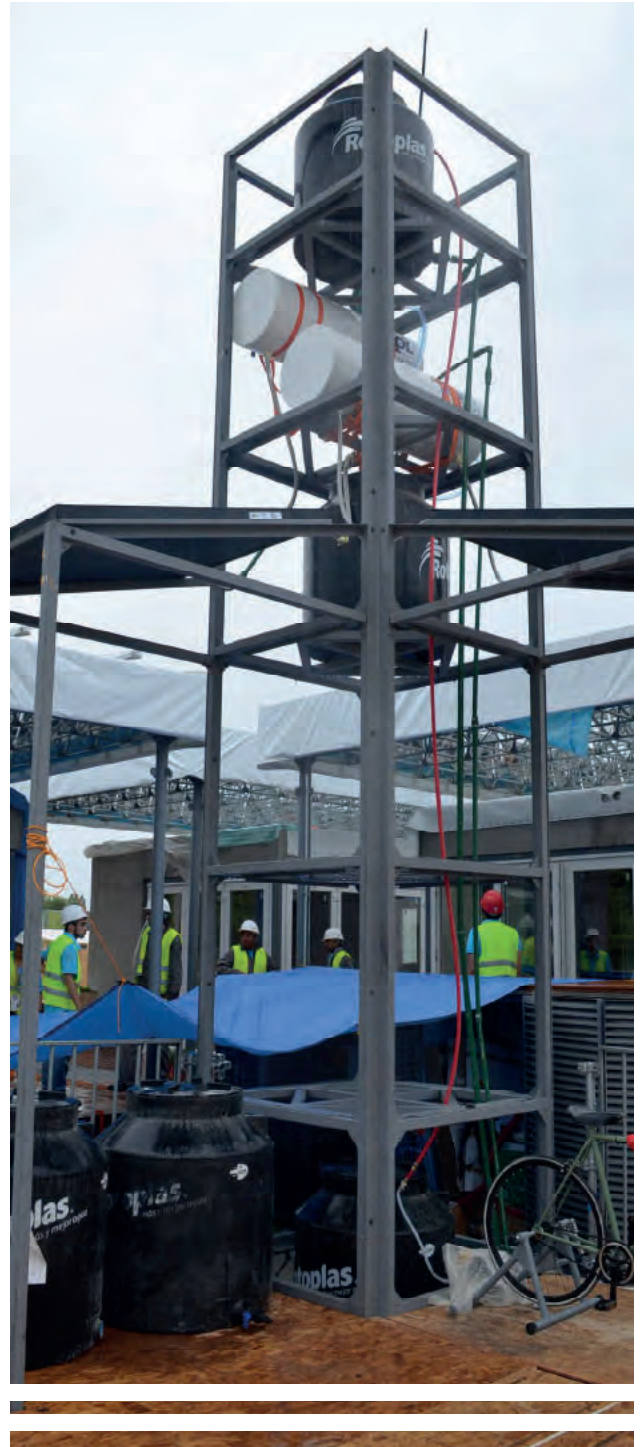
torre hidráulica en construcción en Versailles
