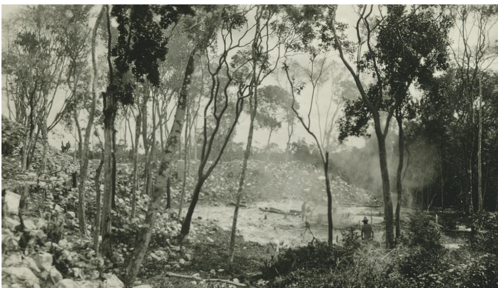
Imágenes 6 y 7) Trabajos de limpieza y desmonte en la zona de la Plaza de las Mil Columnas, mayo de 1926. En el caso de las dos fotos anteriores si sabemos las fechas exactas, pues algunas fotos tienen anotaciones en el reverso.
