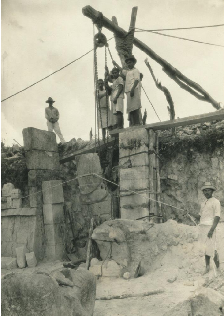
Imagen 2) Reconstrucción de las columnas en forma de serpiente en la entrada del Templo. (1924 c.a.)
