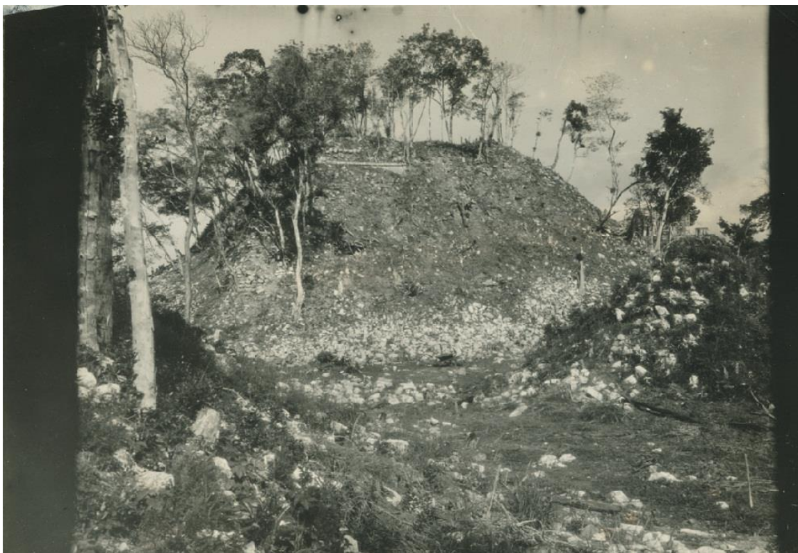
Imagen 1) Templo de los Guerreros antes de los trabajos de reconstrucción (1924 c.a.)
