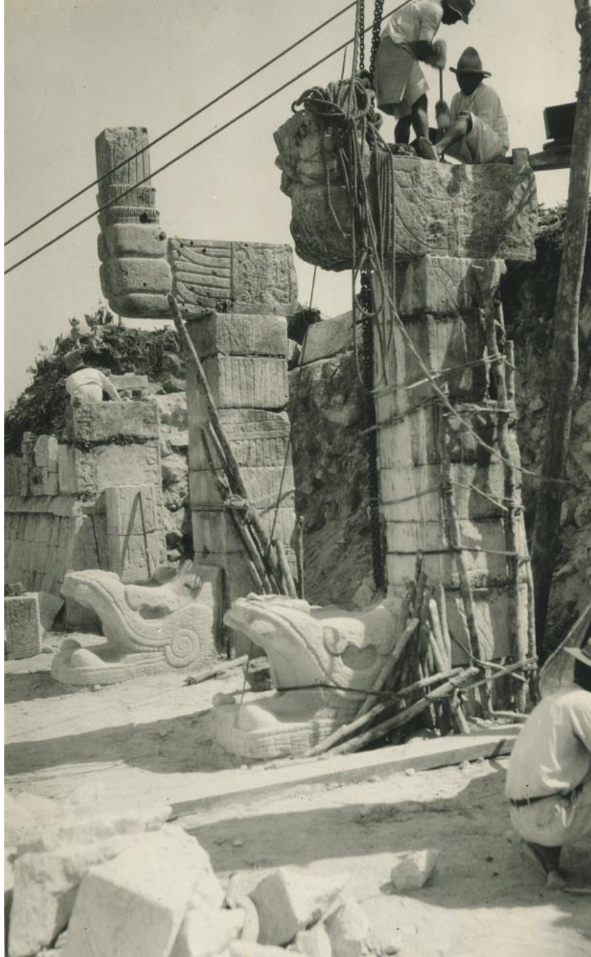
Imagen 3) Reconstrucción de las columnas en forma de serpiente en la entrada del Templo. (1924 c.a.)
