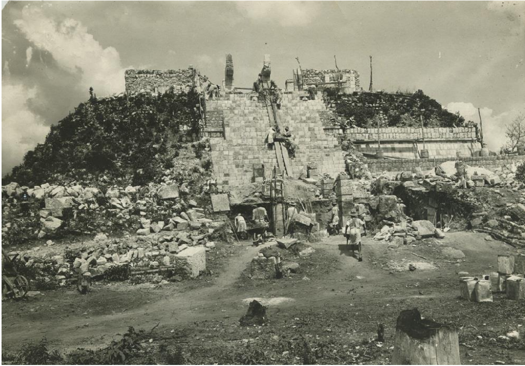
Imagen 9) Trabajos en la fachada del Templo (1925 c.a.)
