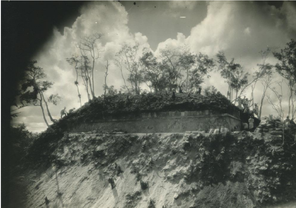
Imagen 4) Vista de los trabajos en el costado norte del Templo (1924 c.a.)
