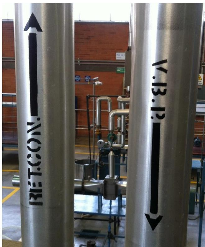
Figura 11. Tubería de Vapor Indicando Flujo y Tipo de Fluido Contenido.
