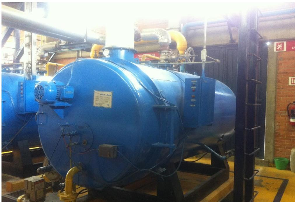
Figura 20. Área de calderas. Instalada en el interior de la Nave 1000 de la Carrera de Ingeniería Química.
