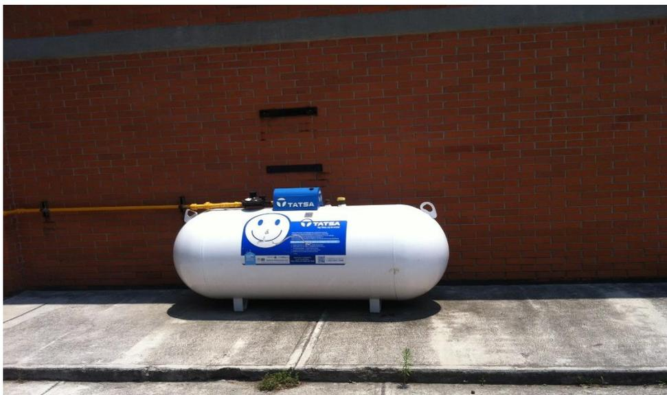
Figura 17. Tanque de gas LP. Instalado en el exterior de la Nave 1000 de la Carrera de Ingeniería Química.
