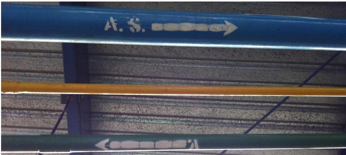
Figura 10. Tubería Respetando Color Contrastante y Señalizando Dirección de Flujo.
