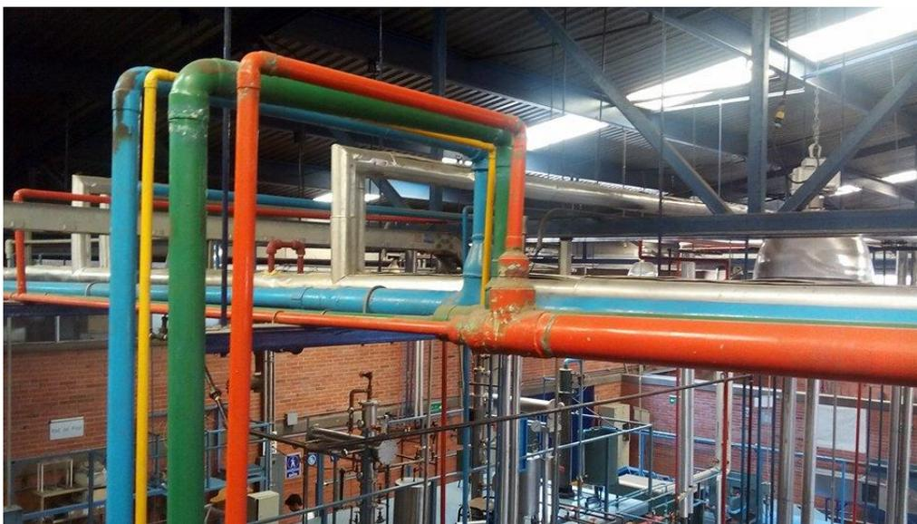
Figura 9. Cabezales de Tubería Proporcionando Determinados Fluidos Respetando Código de Colores.
