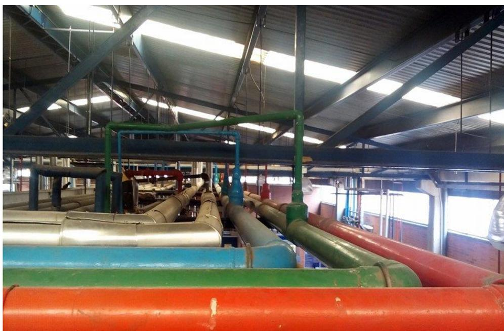
Figura 8. Rack de Tubería Ubicado al Interior de la Nave 1000 Pintado de Acuerdo al Código de
