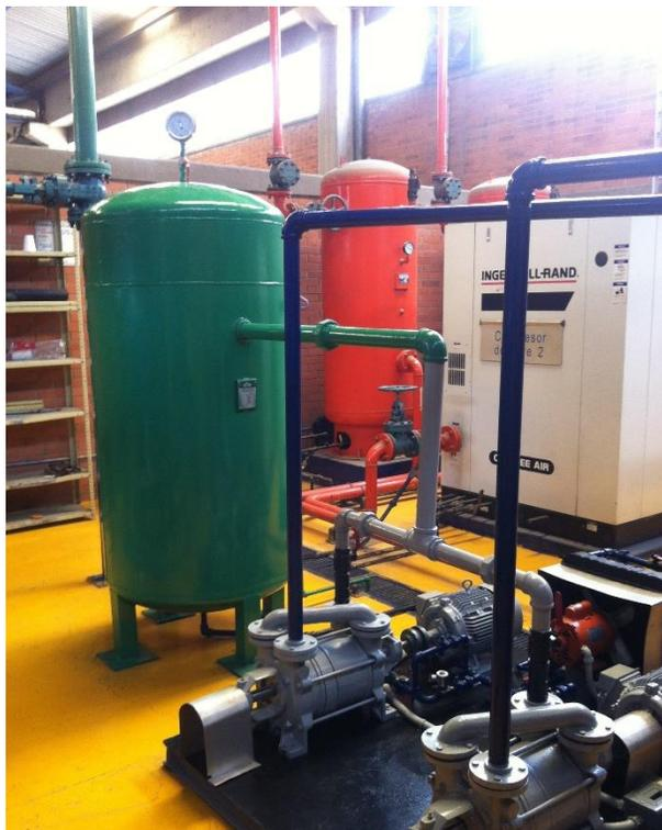
Figura 18. Área de compresores y sistema de vacío. Instalada en el interior de la Nave 1000 de la Carrera de Ingeniería Química.
