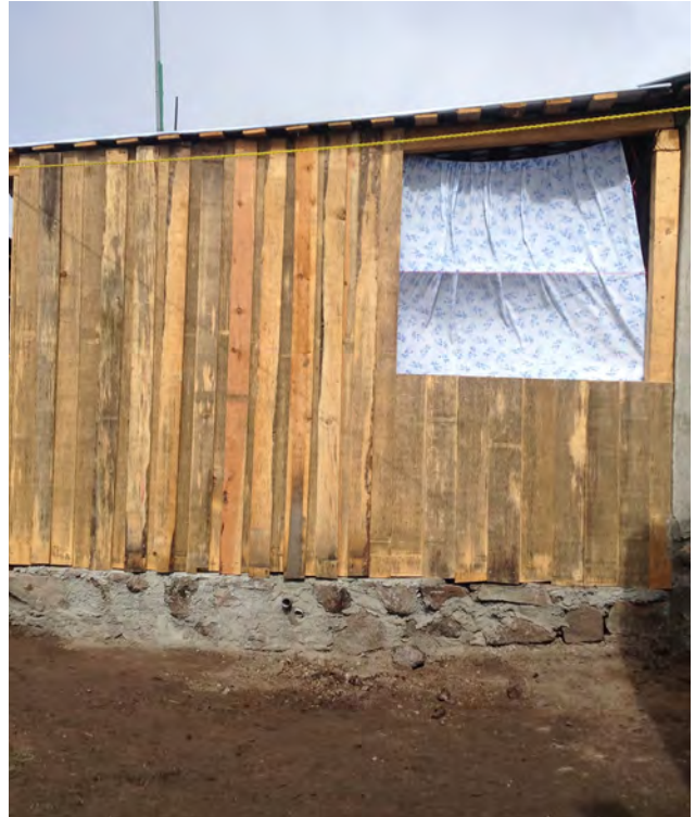
Imagen. 45. Resultado de autoconstrucción de madera en la Región Sierra Norte. Fotografía propia, 2014.
