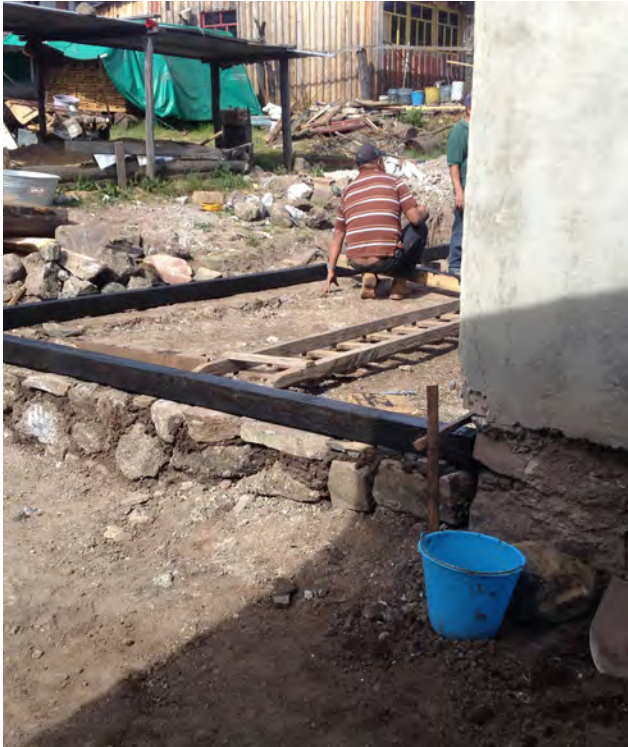
Imagen. 44. Autoconstrucción de viviendas de madera en la Región Sierra Norte. Fotografía propia, 2014.
