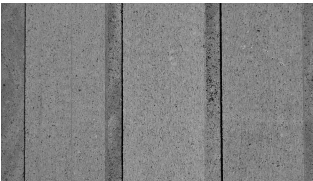
Imagen. 61 . Revestimiento. Fotografía propia, 2015.
