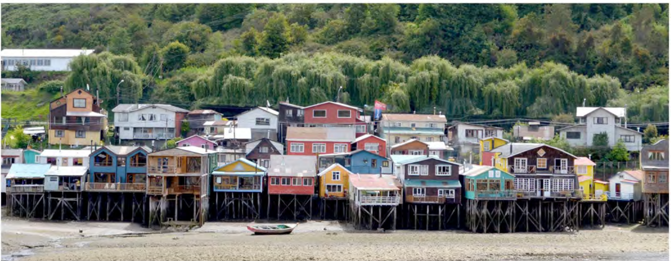
Imagen. 14. Palafitos (Arquitectura vernácula), vivienda de madera con cimentación expuesta en agua constantemente. Isla de Chiloé, Chile. Fotografía propia, 2015.
