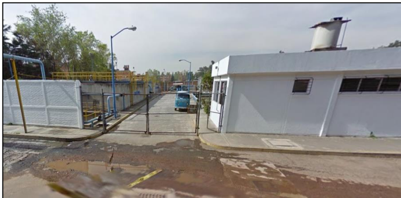
POZO DE AGUA DEL FRACCIONAMIENTO BOSQUES DEL ALBA DESDE EL CIRCUITO BOSQUES NORUEGOS.
