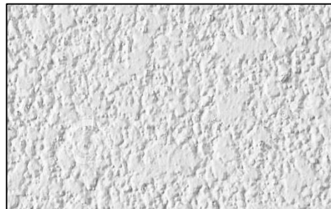
PINTURA EN MUROS INTERNOS
