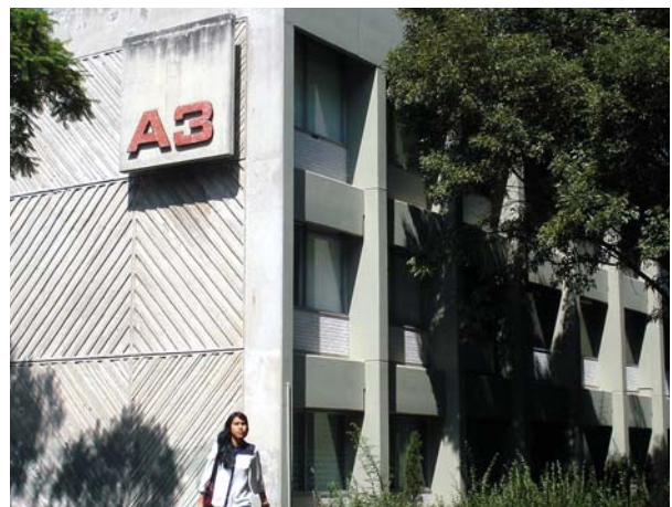
Figura 6. Edificio de aulas A3 de la licenciatura en Diseño Gráfico (abajo).
