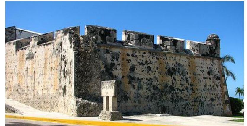
BALUARTE EN CAMPECHE , ARQUITECTURA DISTINTIVA DEL ESTADO.
