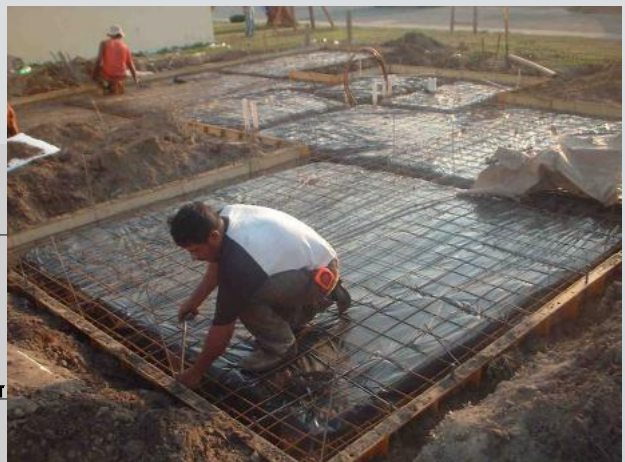
Foto de armado de losa de cimentación
