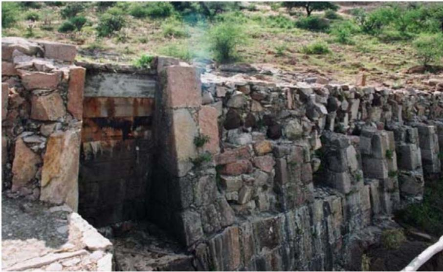
Figura 15.- Vista de los vertedores clausurados con mampostería y compuertas de madera colocadas para elevar el nivel del embalse. (Fuente: <http://www.proteccioncivil.gob.mx>).
