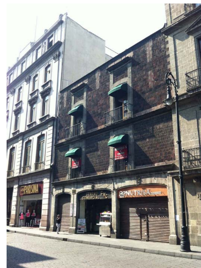
ESTADO ACTUAL DE LA FACHADA VENUSTIANO CARRANZA 67
