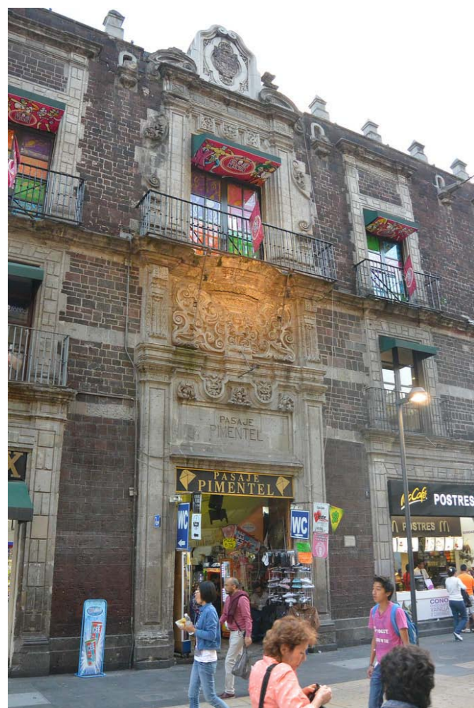
PASAJE PIMENTEL QUE CONECTA LA CALLE DE MADERO CON LA CALLE PEATONAL MOTOLINIA
