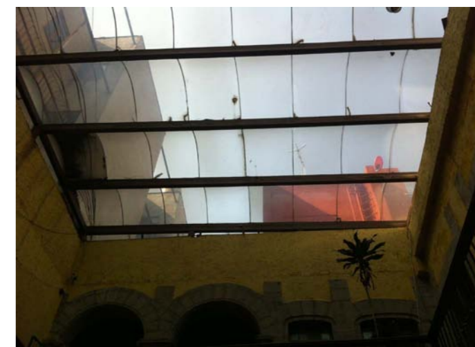
09.CUBIERTA DEL PATIO
