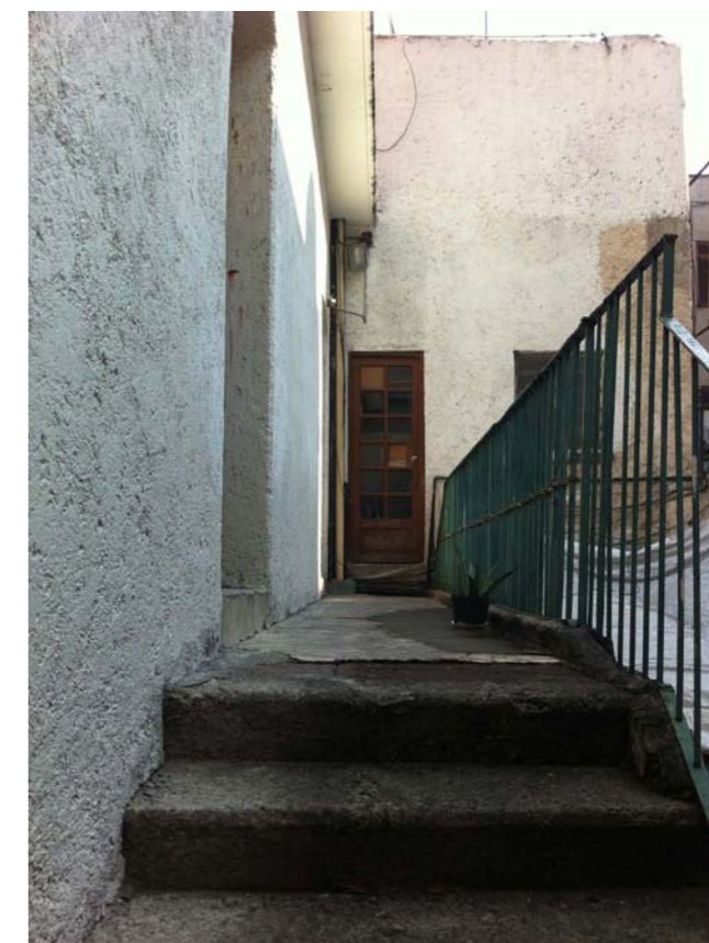
08. ESTADO ACTUAL HACIA EL ÚLTIMO NIVEL DEL EDIFICIO
