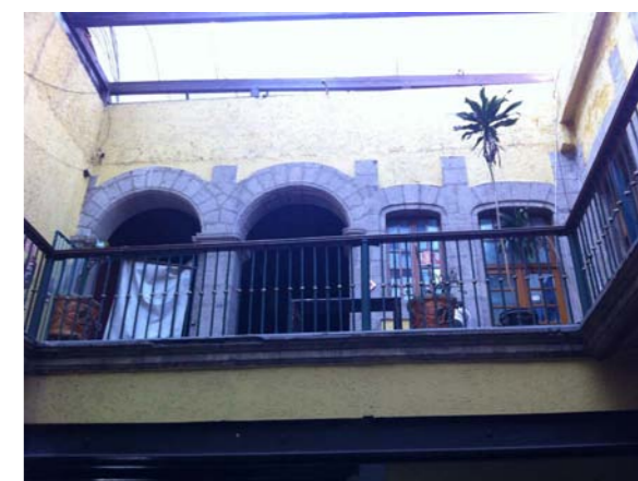
05. PATIO CUBIERTO DEL SEGUNDO NIVEL HACIA EL TERCER NIVEL
