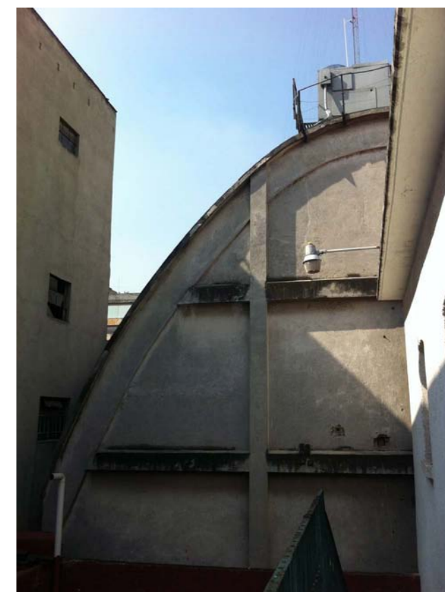
08. FACHADA POSTERIOR DE LA CUBIERTA DE LA SALA DE REMATES
