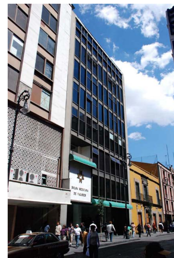
ESTADO ACTUAL DE LA FACHADA DEL EDIFICIO DE LA ANTIGUA BOLSA MEXICANA DE VALORES.
