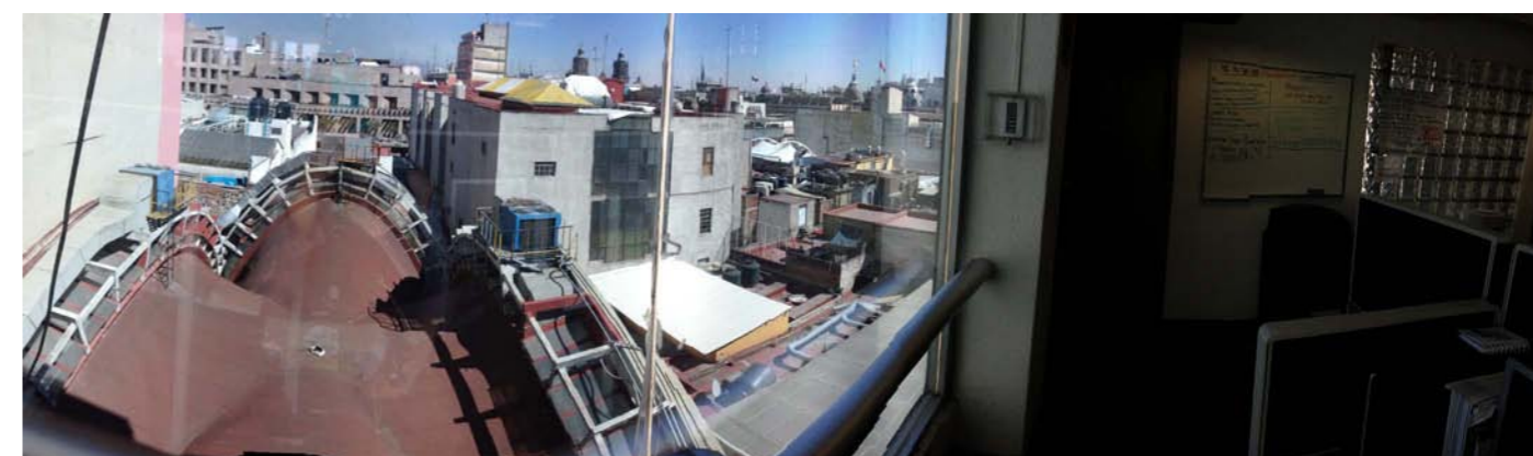
09. EXTERIOR DE LA CUBIERTA DE LA SALA DE REMATES
