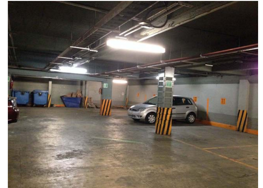
01. ESTADO ACTUAL DEL ESTACIONAMIENTO
