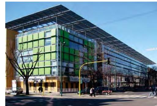
*Fachada del edificio con louvers que permiten y regulan la entrada de luz, en la mayoría del perímetro del edificio se tiene cristal como fachada.*
