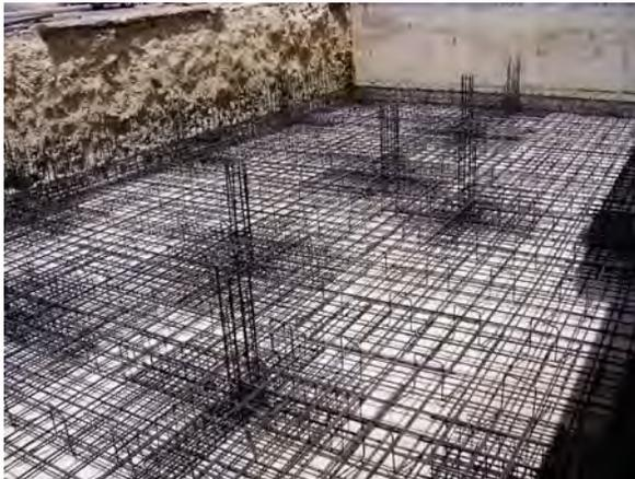
*Losa de cimentación como sistema de cimentación.*
