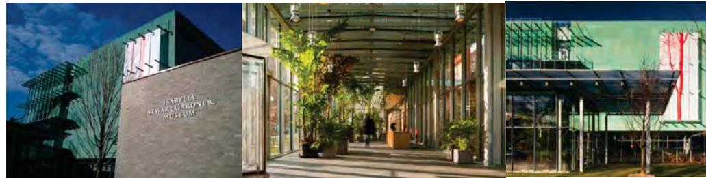
*Fachadas e interior del Museo. Utilización de gran altura para generar diferentes juegos de niveles, pasillos acristalados para obtener mucha luz y con protecciones para evitar el exceso de calor.*
