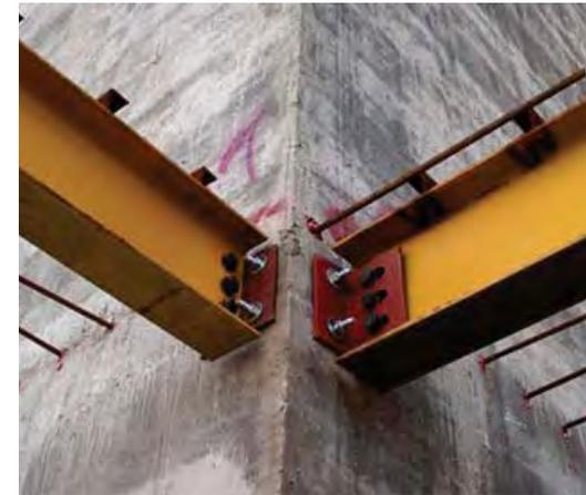
*Sistema constructivo mixto, concreto y acero.*
