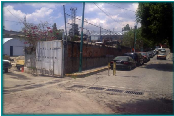
FOTOGRAFÍA 5 VISTA DE LA CALLE CALLEJÓN SAN MARCOS DIRECCIÓN SUR - NORTE
