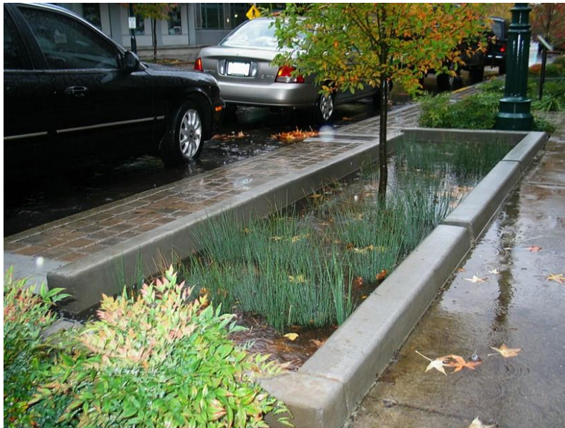
Imagen V.7.Jardinera pluvial Portland, E.U.A 28 .
