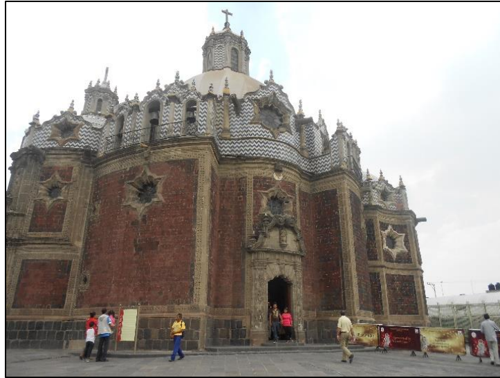
Fotografía 4.1. Arq. Francisco Guerrero y Torres, Capilla del Pocito (s. VIII), Cd. de México. Esta obra combina muros curvos que en planta aparecen como cóncavos y convexos, que le otorgan un aspecto dinámico y la invitación a rodearla. Fotografía de la autora.
