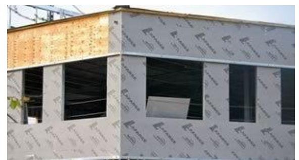
279. Detalle Muro de Durock
