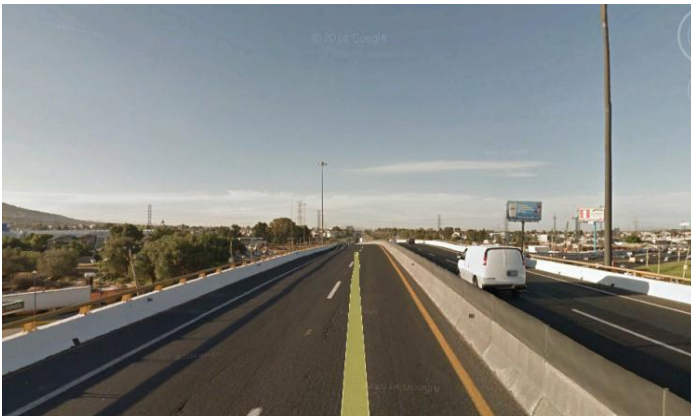
12. Circuito Exterior Mexiquense
