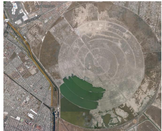
10. Deposito de evaporación El caracol México
