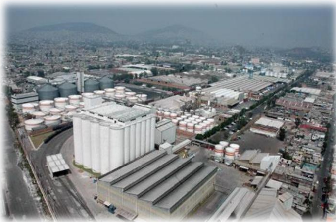
3. Industrialización en el Oriente del Estado de México.
