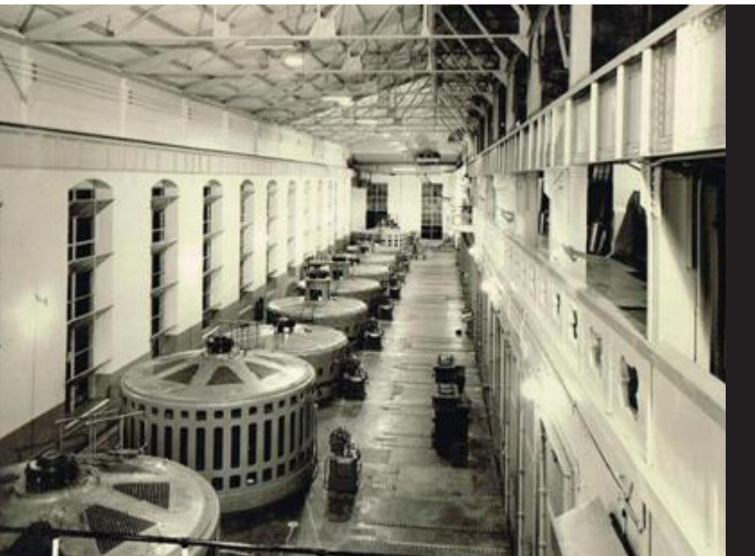
Fig. 8 Presa hidroeléctrica Necaxa, Puebla Fuente: https://is.gd/LeuTBS
