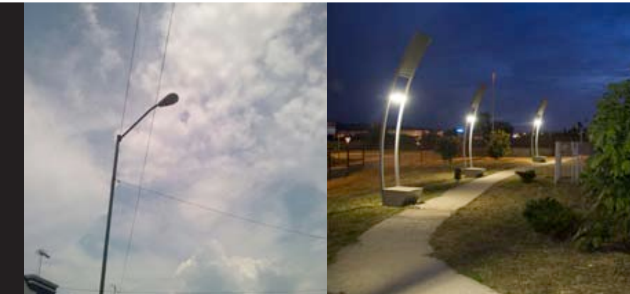
Fig. 85 Luminaria convencional en vías públicas. Fuente: https://is.gd/trKYku
