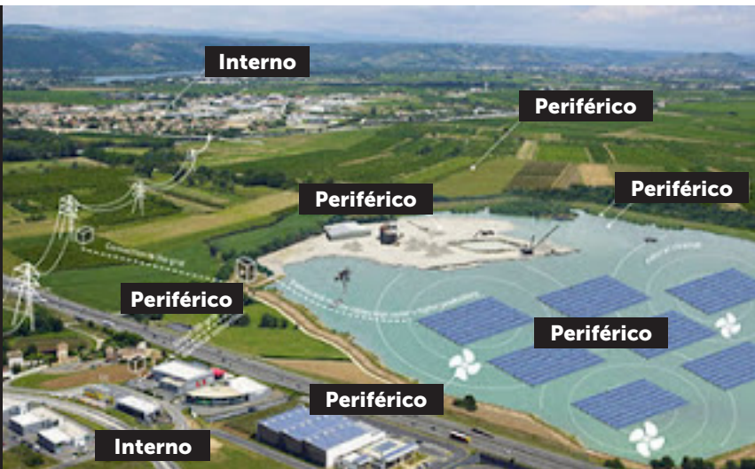
Fig. 15 Paneles internos y en la periferia Fuente: https://is.gd/YEAPAO
