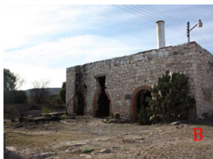
Imagen 25. A) Cuartos de calderas de la fábrica de mezcal de la hacienda Jaral de Berrio. B) Cuarto de calderas fábrica de mezcal Ipiña. C) Cuartos de calderas de fábrica de mezcal Saldaña. En algunos cuartos de calderas no se construía chimenea, solo se prolongaba el tiro metálico de la caldera, además en algunos casos las dimensiones de las calderas exceden las puertas de los cuartos, por lo que estos locales se debieron terminar después de haber instalado la caldera.
