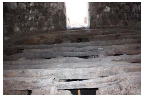
Imagen 10. Parrilla de madera de un horno de la fábrica de mezcal de La Pendencia. (2013).
