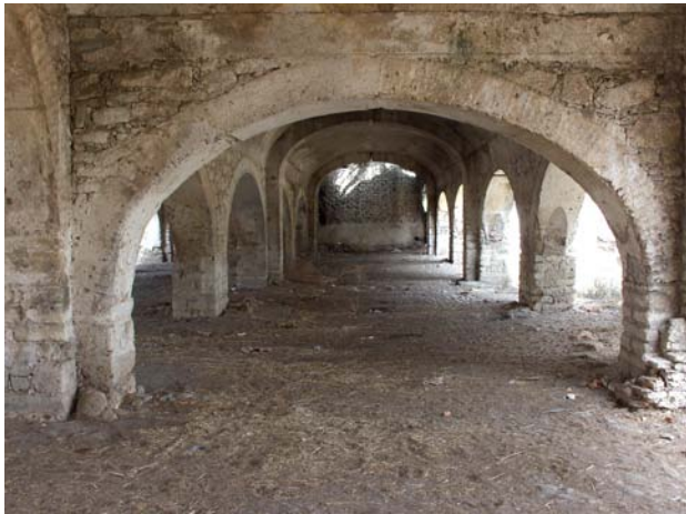
Imagen 27. Establos de la hacienda Jaral de Berrio (2013). Están contruidos a base de bóvedas de cañón corrido hechas de ladrillo, y muros y columnas de mampostería.
