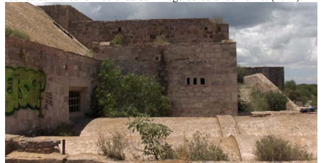
Imagen 8. Cubiertas de los cuartos de calderas, naves de destilación y fermentación. Ambas imágenes de la fábrica de mezcal de Jaral de Berrio. (2012).
