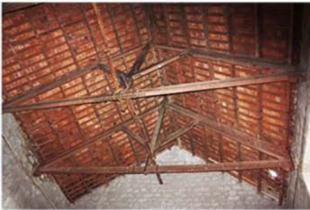
VISTA DEL INTERIOR DE LA CUBIERTA
