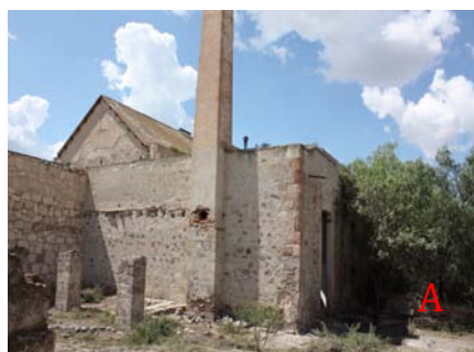
Imagen 25. A) Cuartos de calderas de la fábrica de mezcal de la hacienda Jaral de Berrio. B) Cuarto de calderas fábrica de mezcal Ipiña. C) Cuartos de calderas de fábrica de mezcal Saldaña. En algunos cuartos de calderas no se construía chimenea, solo se prolongaba el tiro metálico de la caldera, además en algunos casos las dimensiones de las calderas exceden las puertas de los cuartos, por lo que estos locales se debieron terminar después de haber instalado la caldera.
