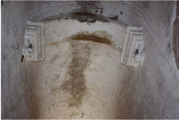
Imagen 16. Impostas de un arco fajón en las bóvedas de la nave de fermentación. Fabrica de mezcal jaral de Berrio (2013). La ornamentación de las impostas donde descansan los arcos fajones representan parte de las costumbres de construcción de finales del siglo XIX.
