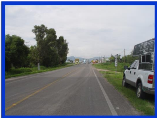
KM 35+000 VISTA HACIA EZEQUIEL MONTES
