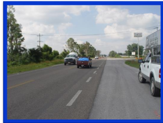
KM 32+000 VISTA HACIA EZEQUIEL MONTES
