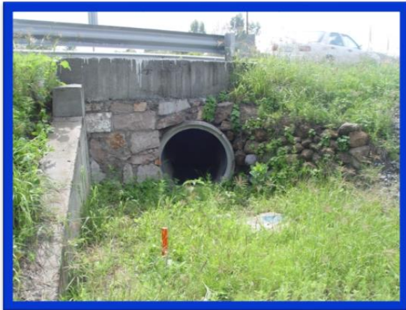
OBRA DE DRENAJE KM 30+384.98 TC DE 0.90 m Ø
