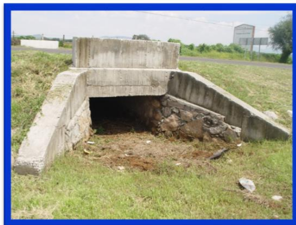
OBRA DE DRENAJE KM 33+576.66 LC 1.35 X 0.70 m
