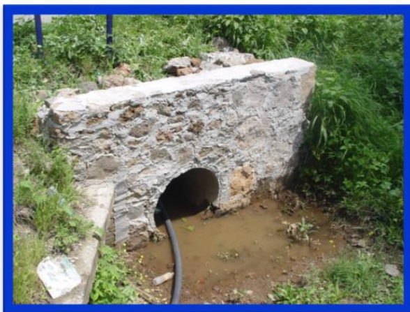
OBRA DE DRENAJE KM 32+572.57 TC DE 0.90 m Ø
