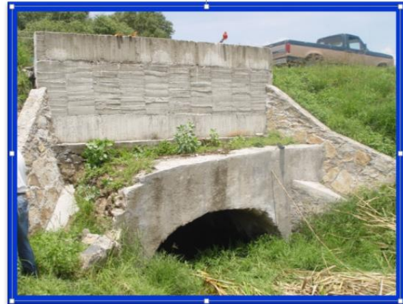
OBRA DE DRENAJE KM 31+264.95 A 3.30 X 1.30 m
