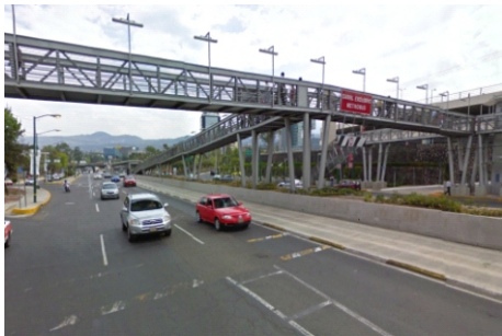
P3. Puente Metrobús estación Perisur
