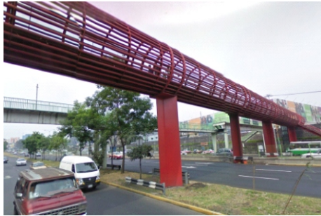
P1. Puente Centro Comercial Perisur
