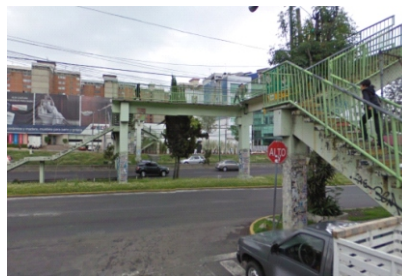
P5. Puente Calle John F. Kennedy
