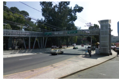
P6. Puente Metrobús estación Villa Olímpica
