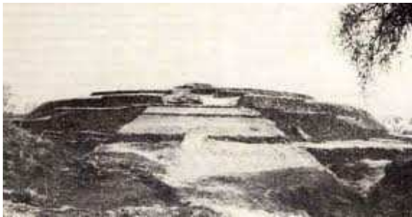
Imagen 11. Vista general de la pirámide con la rampa occidental. 1980 22
