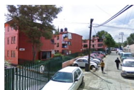
Vista Calle Zapote
