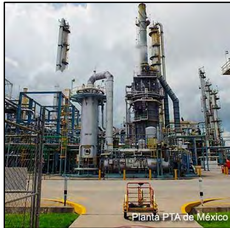
Figura. 2.15. Planta de Petrotemex ubicada en Altamira
