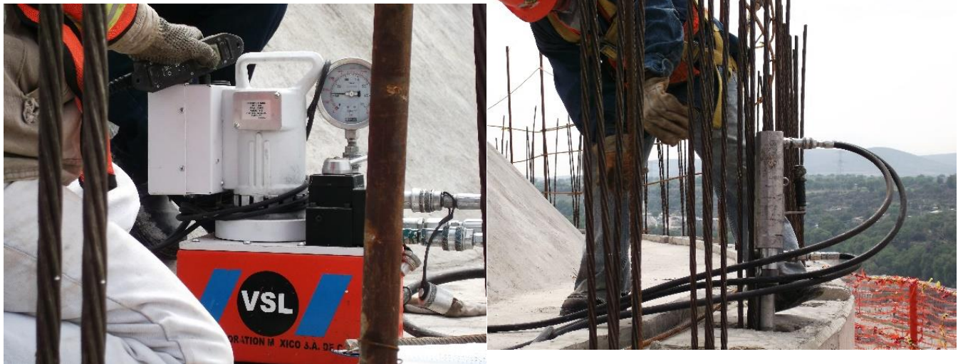
ILUSTRACIÓN 52 EQUIPO APLICÁNDOLE TENSIÓN EN CABLES TORONES VERTICALES
