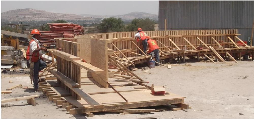
ILUSTRACIÓN 37 HABILITADO DE CIMBRA PARA MUROS DESLIZADOS
