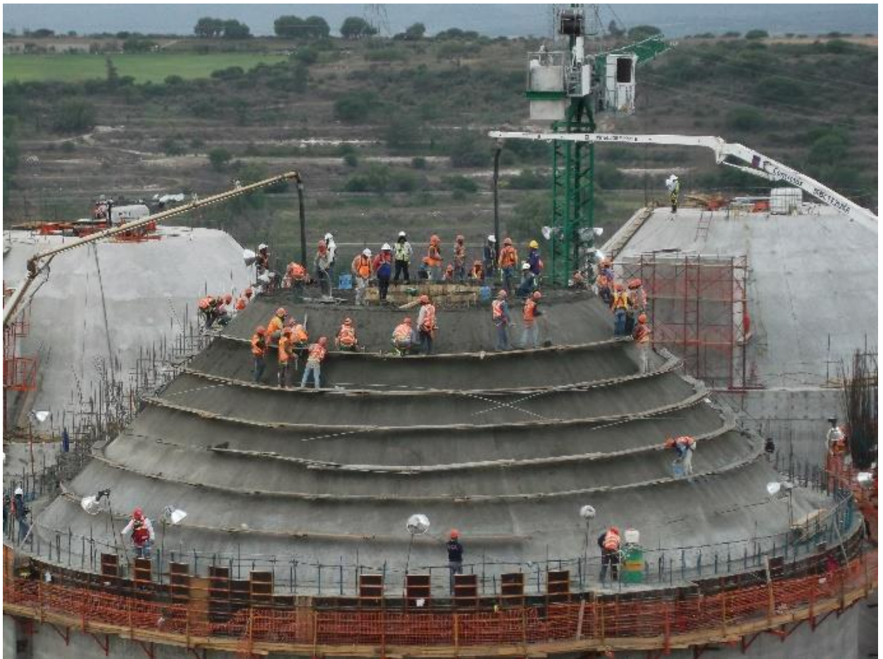
ILUSTRACIÓN 49 COLOCACIÓN DE CONCRETO EN LOSA TAPA
