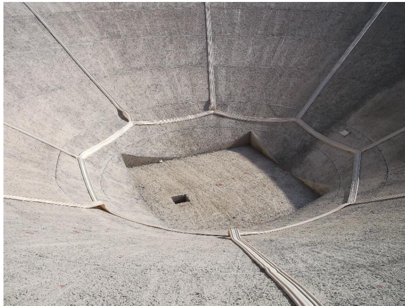
ILUSTRACIÓN 24 BANDA DE PVC COLOCADA SOBRE LA PLANTILLA
