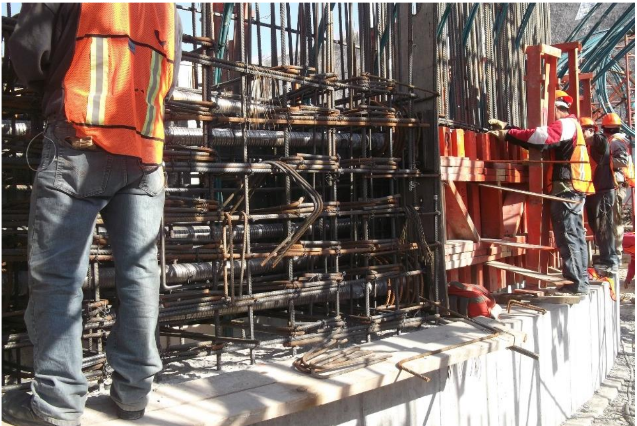
ILUSTRACIÓN 39 COLOCACIÓN DEL MOLDE DE CIMBRA PARA MURO
