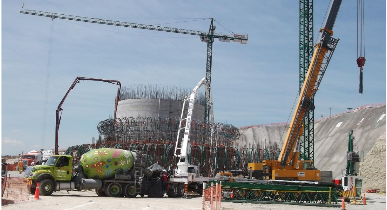
ILUSTRACIÓN 40 EQUIPO DE IZAJE, BOMBA DE CONCRETO Y EQUIPO DE SUMINISTRO DE CONCRETO
