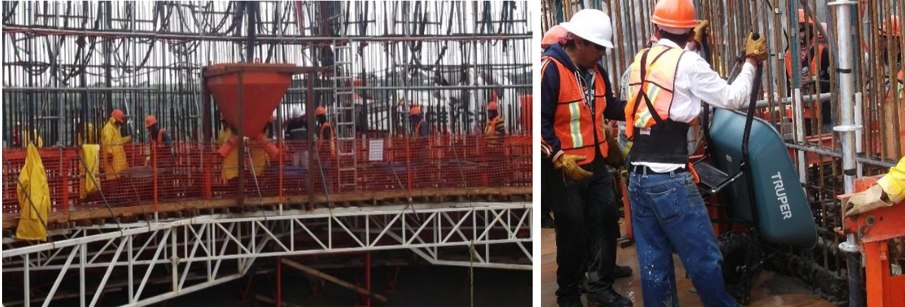
ILUSTRACIÓN 4 1 IZQ. TOLVA RECEPCIÓN DE CONCRETO. DER. VACIADO POR MEDIO DE CARRETILLA
