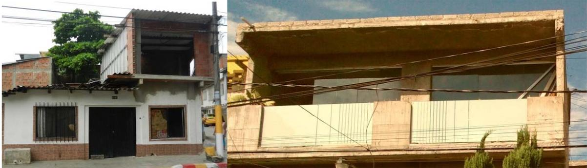
A la izquierda, proceso de construcción con Dry wall, paneles de fibrocemento y entrepiso con lámina colaborante en el Barrio Berlin de Cali. A la derecha antepecho y baranda del balcón en vidrio laminado, templado y con película opalizada en la colonia Pedregal Santo Domingo. México D.F. Fuente: registro Propio. 2014
