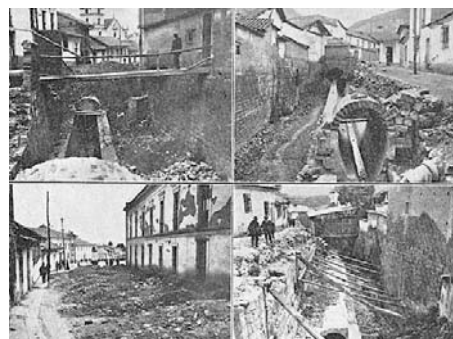
Imagen 59 Obras canalización Río San Agustín.
