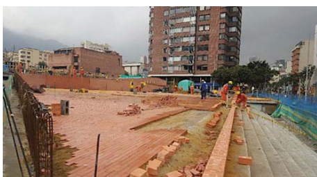
Imagen 100 1. Proyecto del Parque Bicentenario de 2011; 2.Estado de la obra en el 2014; 3. Reanudación de obras en 2015
