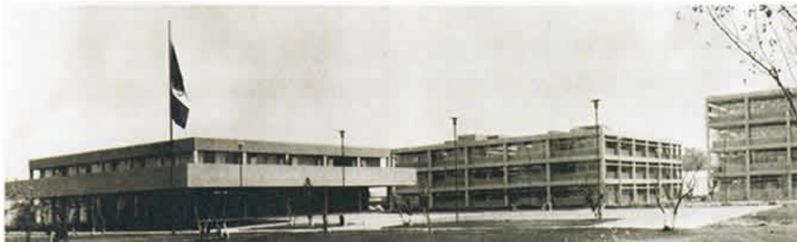
Figura 1.2. Vista de Edificio de Rectoría y los Edificios de Laboratorios Ligeros.
