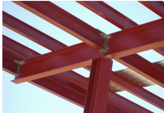
Figura 6.13. Conexión soldada.
