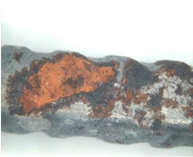
Figura 41 Acero de la probeta N-III-1 se observa una zona altamente afectada por corrosión
