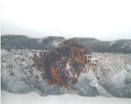
Figura 43. Zona corroída en el acero de la probeta N-II-1
