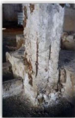
Figura 7: Ataque por ácidos en una columna
