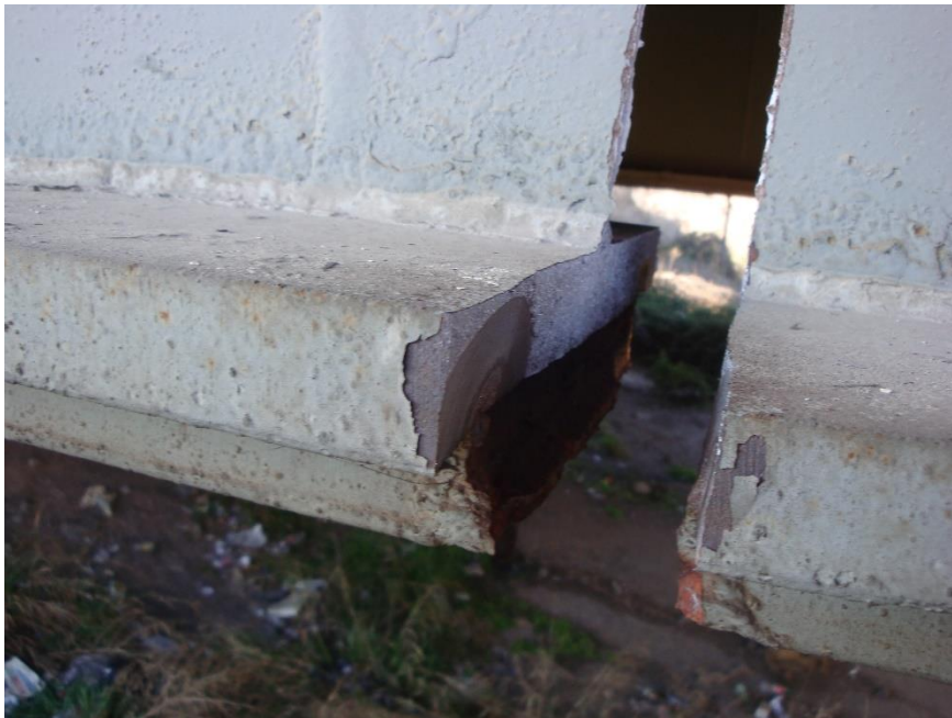
Figura 1.2 Fractura por fatiga [web]
