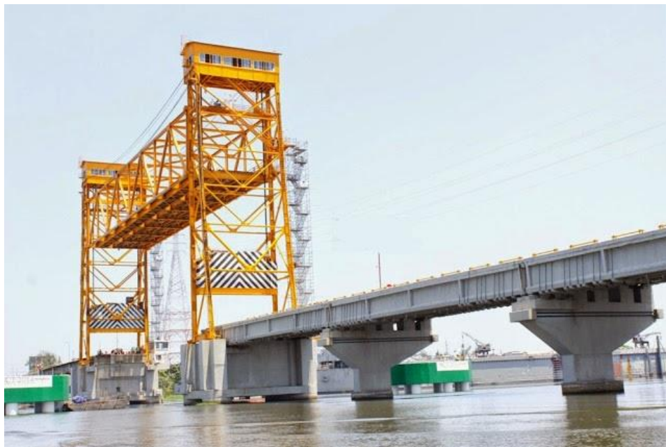
Figura 3.21 Cimentación en extremos de armadura
