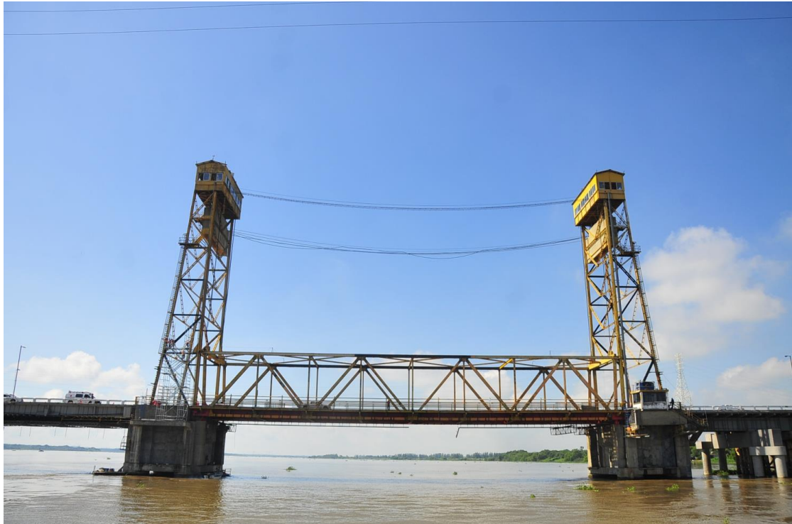
Figura 3.10 Sistema de torres para elevado de armadura
