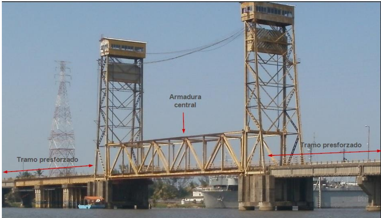
Figura 3.7 Estructura general del puente Coatzacoalcos I [22]
