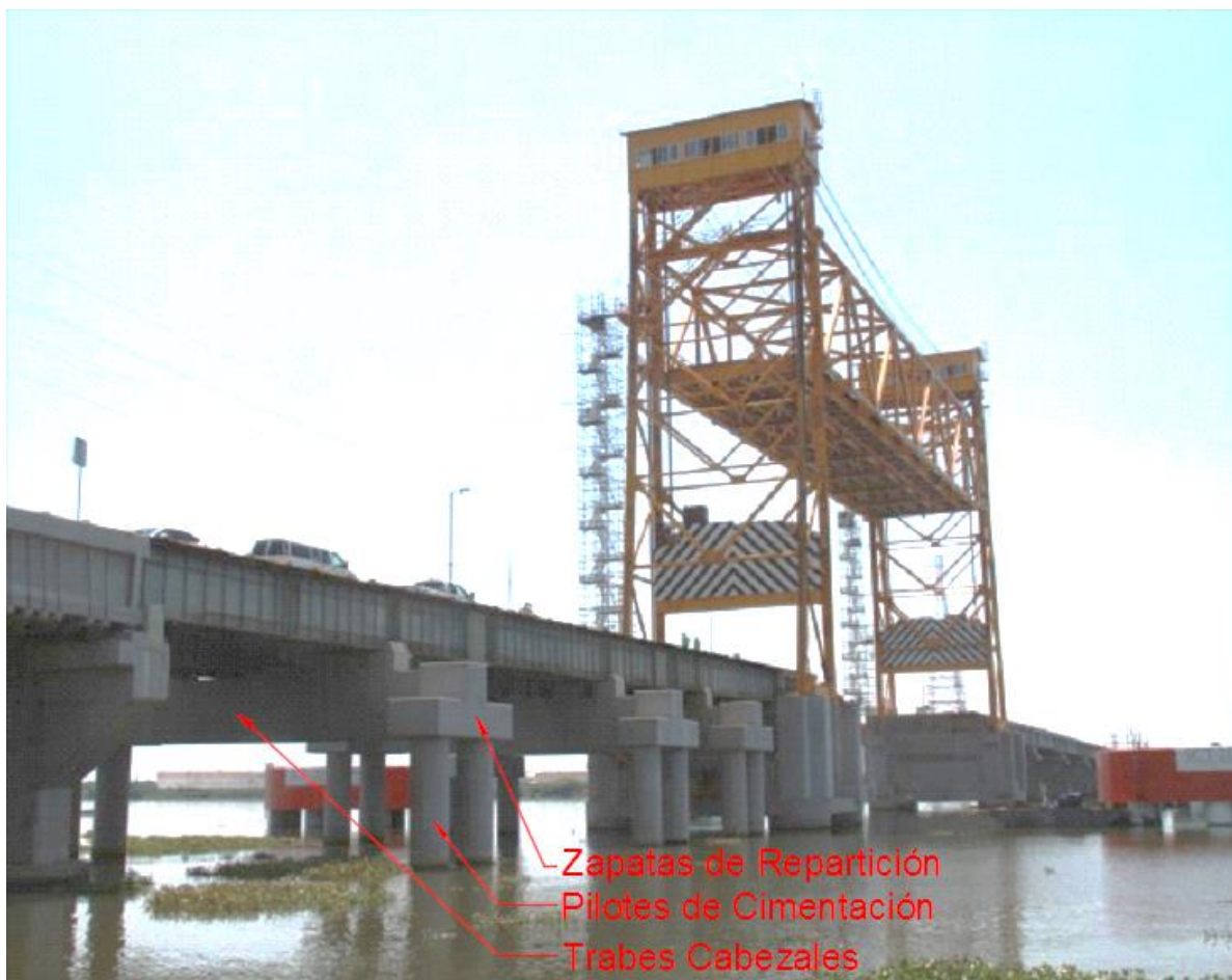
Figura 3.17 Cimentación reconstruida
