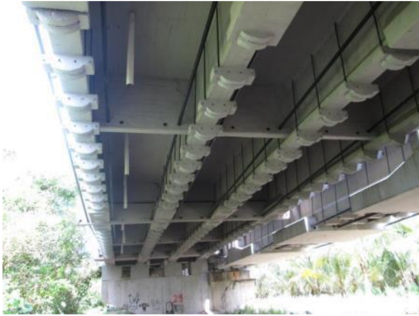
Figura 3.3 Refuerzo colocado en vigas [20]
