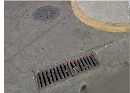
IMÁGEN: Alcantarilla FUENTE: Elaboración Propia. José Manuel Pérez Cisneros
