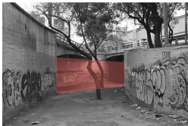
Fig. 3.3 Parte mas baja del terreno 1 que no tiene protección.
