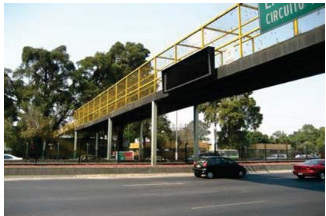
Fig. 4.10 Foto tomada desde calzada de Tlalpan hacia un ejemplo típico de puente peatonal en la Ciudad de México.
