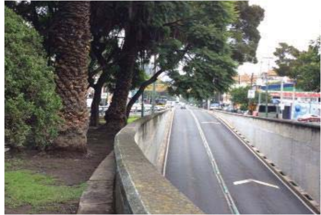
Fig. 2.11 Borde norte, con el muro de contención delimitando el terreno 2.
