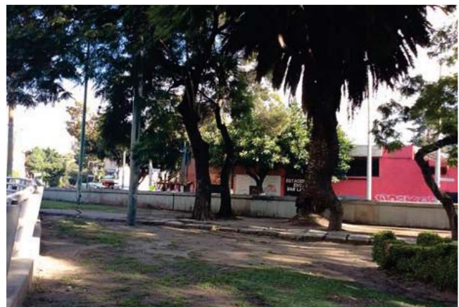
Fig. 2.41 Postes de luz sobre el terreno B.
