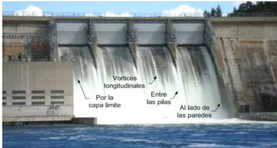
Fig. 12 Formas de arrastre de aire de un vertedor – Canyon Ferry Montana.
