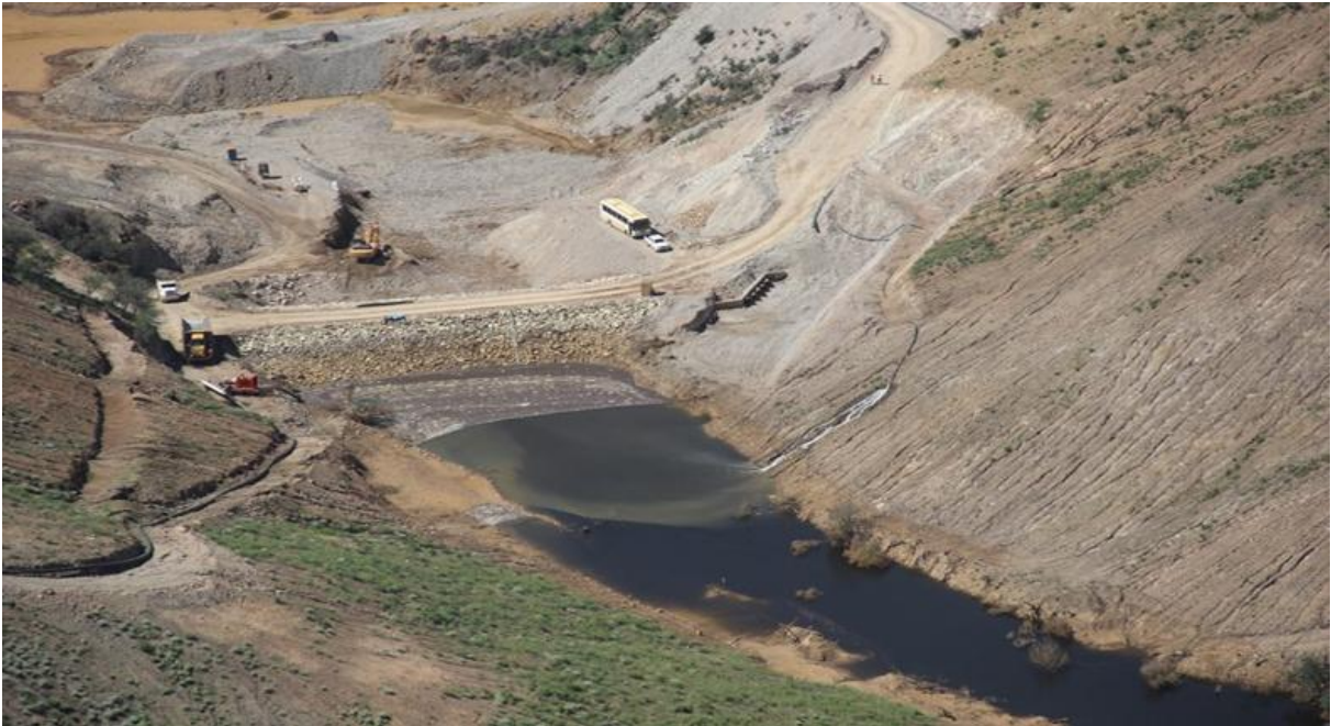
Ilustración 13 “ Vista aérea del río de Sonora después del accidente ”. El Universal (2014).
