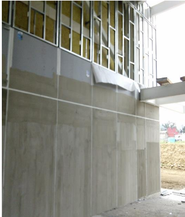
Figura III.56 Habilitado de muros de tablavento en núcleo de escaleras.
