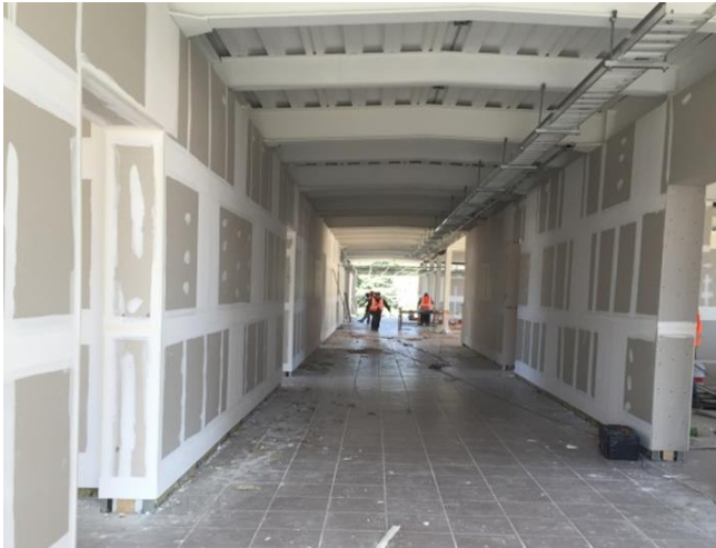
Figura III.69 Calafateado de muros de tablaroca en ambas caras.
