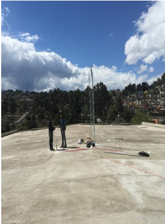
Figura III. 79 Montaje de punta de pararrayos en azotea
