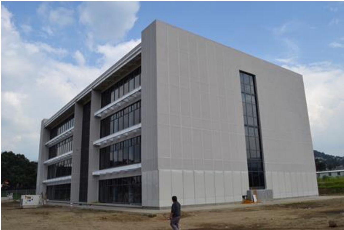
Figura III.81 Fachadas norte y poniente concluidas.
