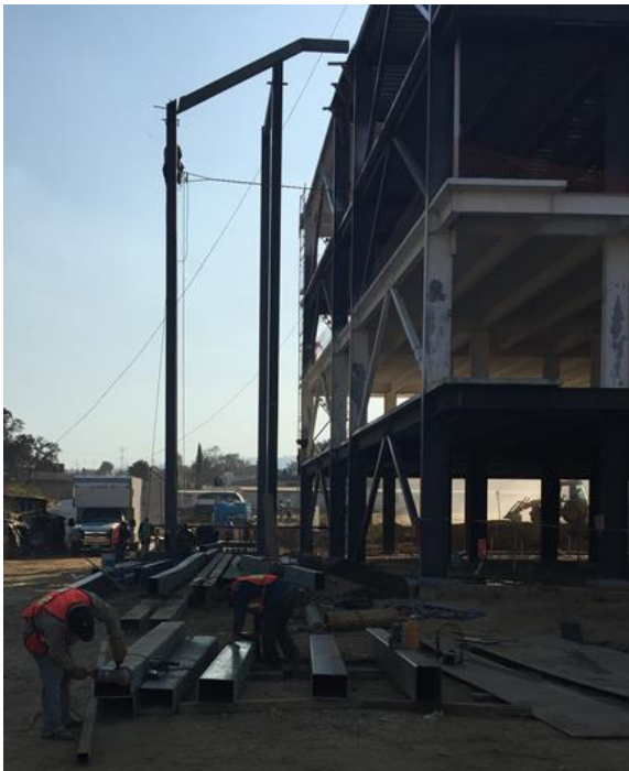
Figura III.58 Montaje de columnas metálicas para la escalera de emergencia.
