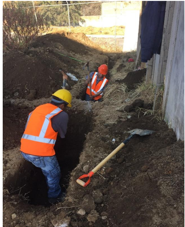
Figura III.66 Excavación de zanjas para instalaciones eléctricas de media tensión.
