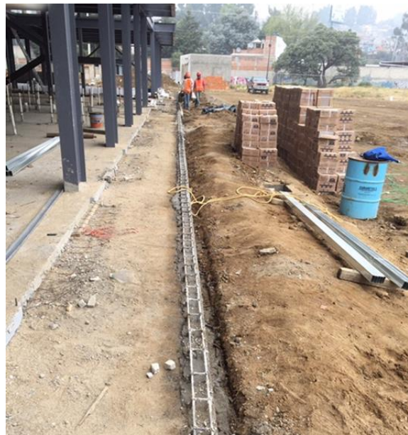
Figura III.62 Preparación de guarniciones para andadores en exterior de edificio.
