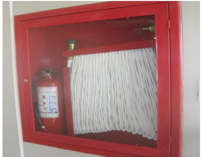
Figura III.31 Colocación de gabinete del sistema contra incendios.
