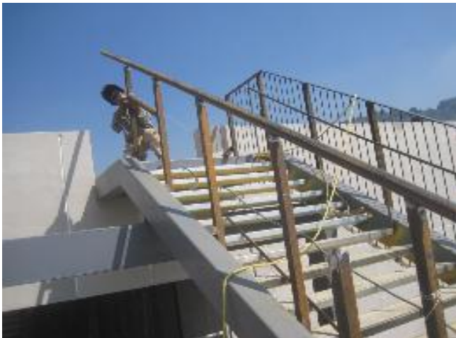
Figura III.78 Habilitado y colocación del barandal en escalera de emergencia.
