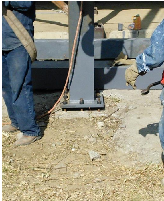
Figura III.58 Montaje de columnas metálicas para la escalera de emergencia.
