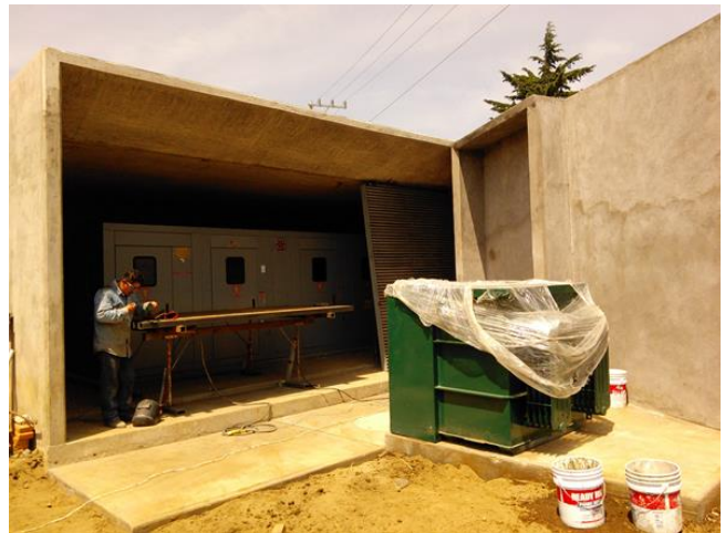
Figura III.39 Instalación de equipos de subestación
