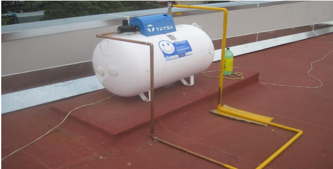
Figura III.41 Aplicación de pintura a instalaciones de gas.
