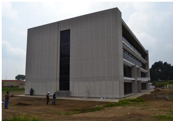
Figura III.14 Fachada sur y poniente
