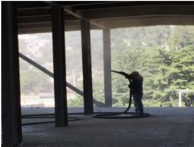
Figura III.47 Sandblasteo de estructura metálica.
