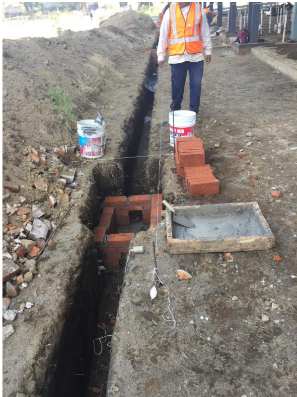
Figura III.51 Construcción de registro sanitario
