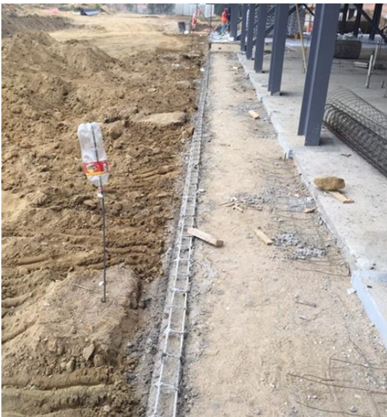
Figura III.62 Preparación de guarniciones para andadores en exterior de edificio.
