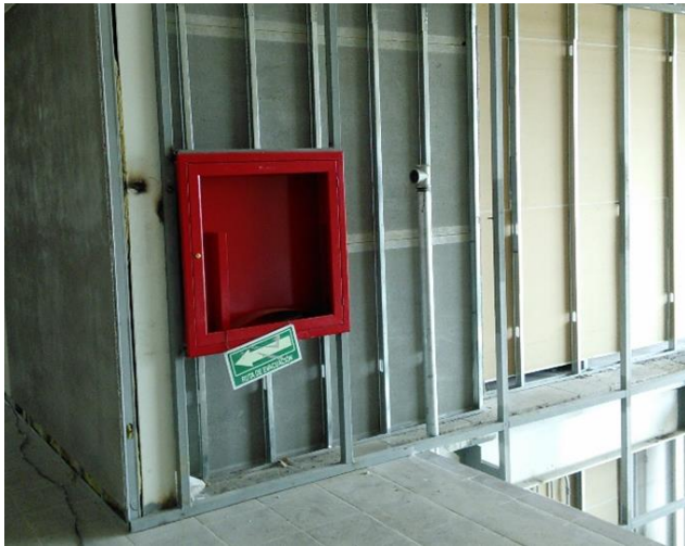
Figura III.31 Colocación de gabinete del sistema contra incendios.
