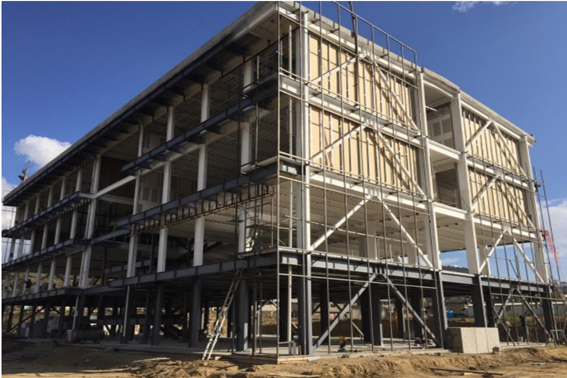
Figura III.61 Avance general de los trabajos del edificio.
