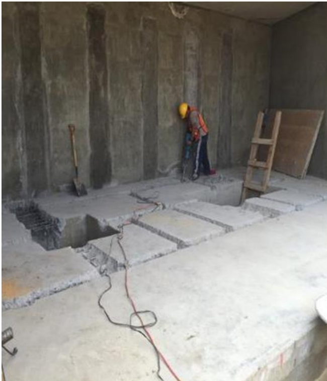
Figura III.65 Preparaciones a subestación para recibir equipos
