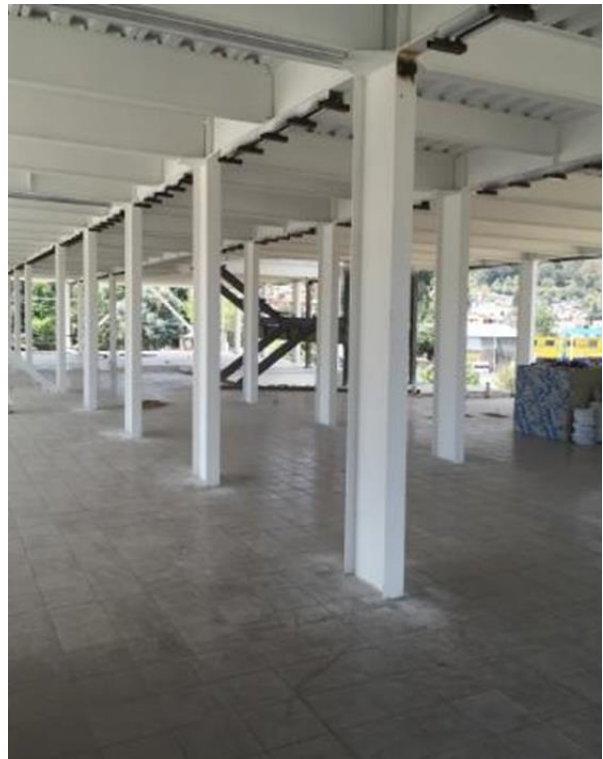
c) Aplicación de pintura intumescente en estructura metálica.
