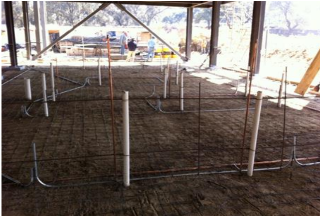
Figura III.53 Preparación de instalaciones hidrosanitarias en planta baja
