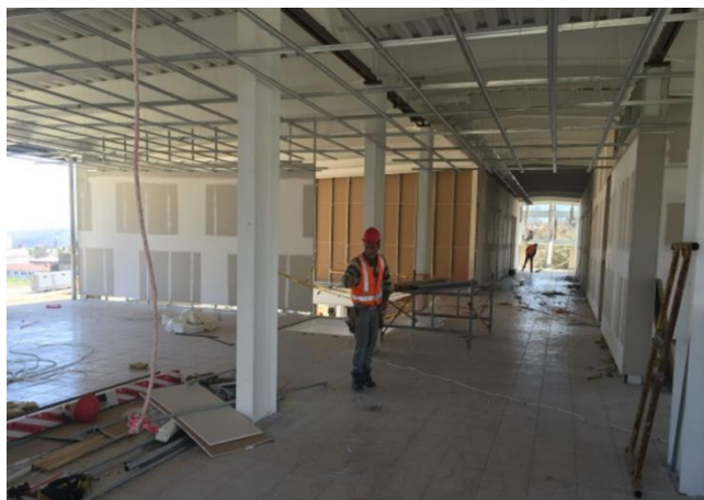
c) Colocación de tablaroca en muros.
