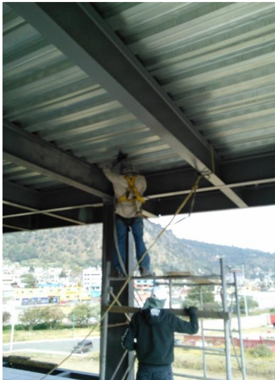
b) Aplicación de primario en estructura metálica
