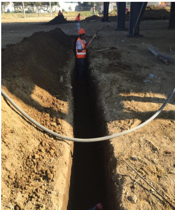
Figura III.25 Excavación de zanja para tendido de drenaje
