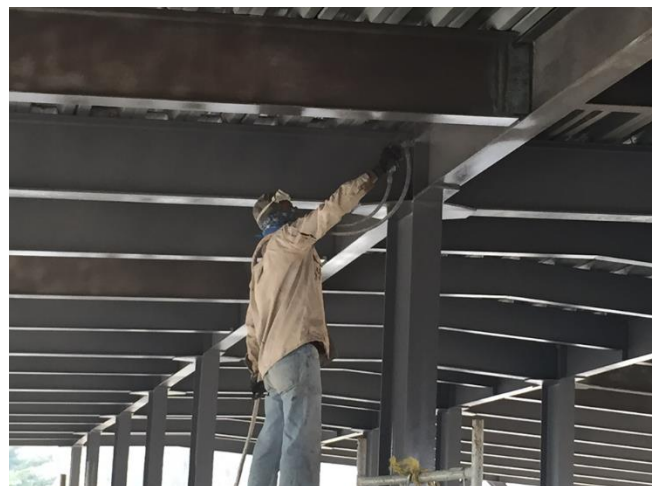
Figura III.48 Aplicación de primario en estructura metálica.
