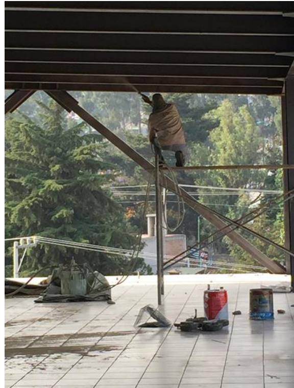
a) Limpieza de estructura metálica mediante sandblast.
