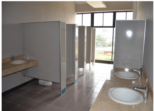
Figura III.71 Suministro de mamparas de lámina porcelanizada y muebles para baños.
