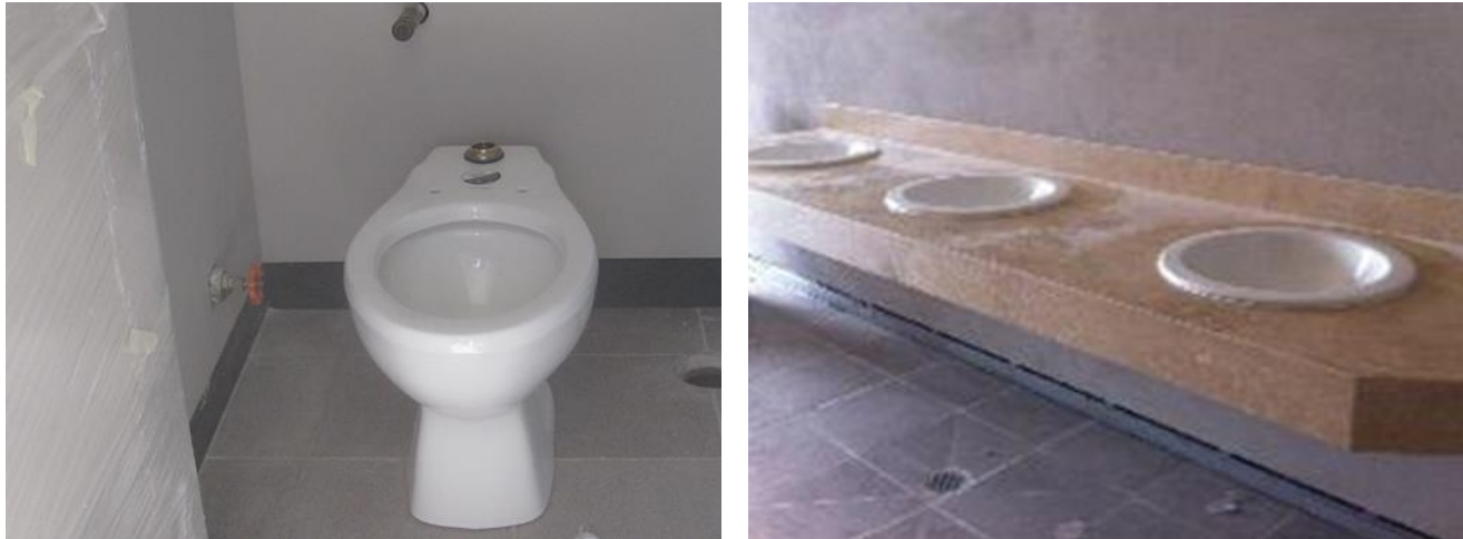
Figura III.27 Suministro y colocación de muebles de baño.
