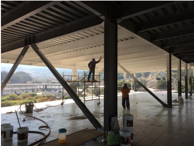
Figura III.49 Aplicación de pintura intumescente en estructura metálica
