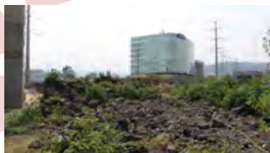
Área frente a edificio "D" (Fotografía 1)
