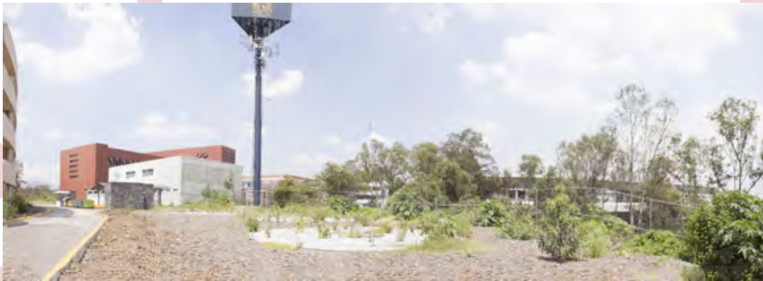
Vista desde vialidad a zona de corteza frente a edificio "F".
