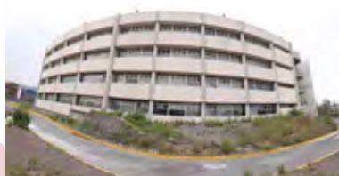
Talud frente edificio "J" (Fotografía 4)
