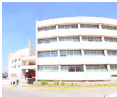
Acceso Sur (Fotografía 6)
