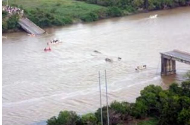
**Figura 1.4** Puente Tonalá, colapso total por socavación de 11m bajo sus apoyos durante el huracán Stan
