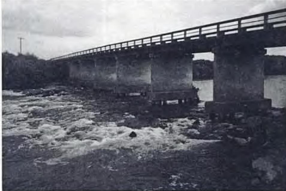
**Figura 1.5** Puente Oreti en Nueva Zelanda. Socavación en las pilas sobre el cauce. (Melville y Coleman, 2000)
