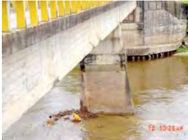
**Figura 1.2 Desplazamiento de pilas en el puente Banadia en Colombia**
