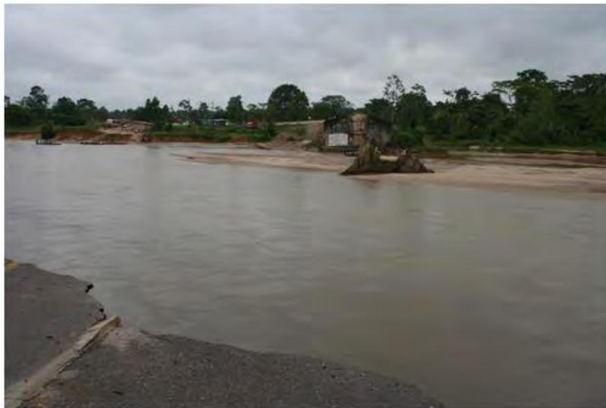
**Figura 1.3 Puente Banadia Colapso total. Revista Ingeniería de Construcción Vol. 28 N°1, Abril de 2013 [www.ricuc.cl](http://www.ricuc.cl) PAG. 37 – 62**
