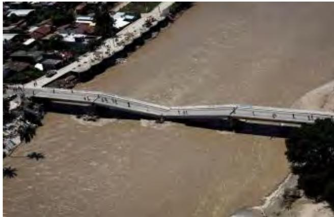
**Figura 1.1** Colapso de la superestructura del puente “Coyuca de Benítez” al presentarse socavación bajo sus apoyos. Fuente: [www.eluniversal.com.mx](http://www.eluniversal.com.mx)
