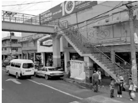
Imagen: Puente peatonal sobre Av. Pantitlán Fuente: http://www.excelsior.com.mx/
