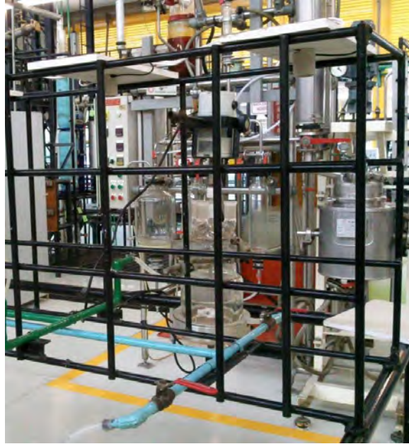
Fig.-34- Colocación de focos.
