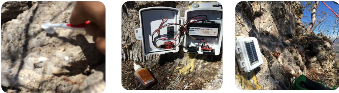
Figura 50. Limpieza del sitio donde se realizó el montaje y montaje de los sensores.
