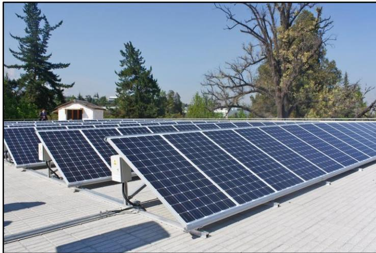
Figura 34. Paneles fotovoltaicos para suministro de los equipos eléctricos del área de comedor
