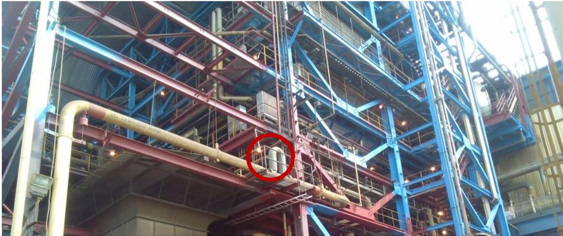
Figura 104. Medidores de flujo por efecto coriolis empleados para la medición de flujo másico de gas natural, instalados en la C.T. Francisco Pérez Ríos.
