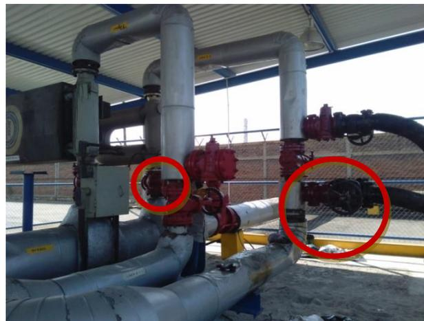
*Figura 91. Ajuste de cero al cerrar las válvulas de compuerta indicadas.*
