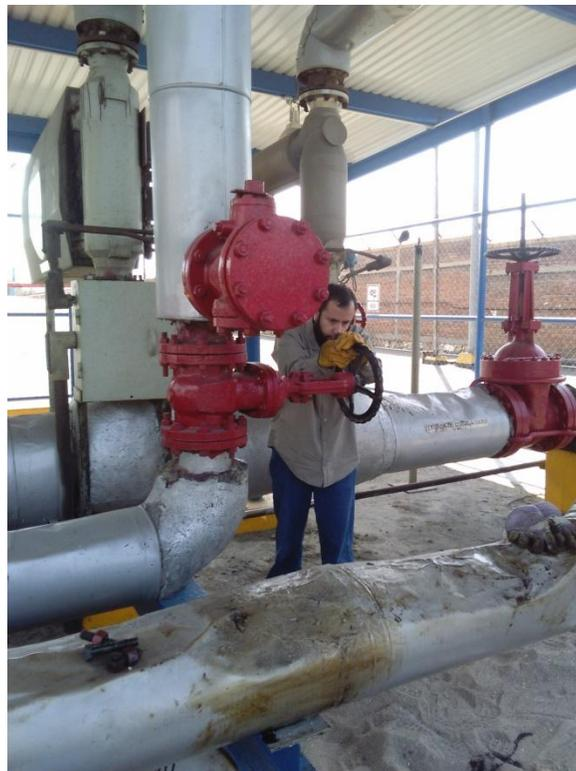
Figura 93. Manejo del volante de la válvula de compuerta de la línea 1 para variar el flujo.
