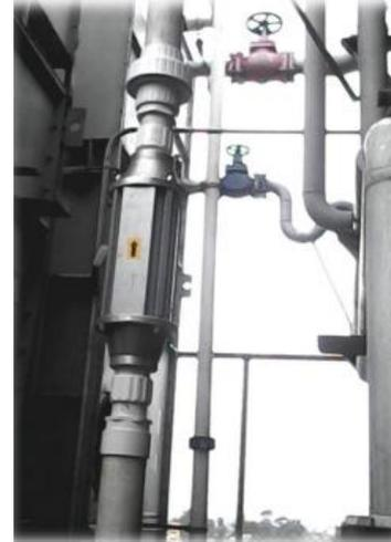
*Semiceldas electroquímicas instaladas en el sistema de tuberías.*
