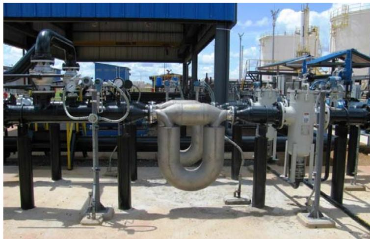
*Figura 54. Medidores de flujo por efecto coriolis instalados en una EMRyC.*
