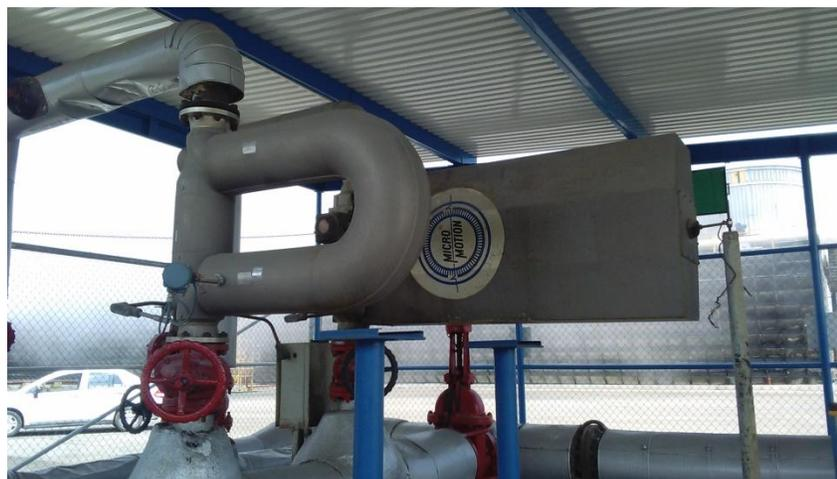
*Figura 74. Medidores de flujo por efecto coriolis instalados en la estación de medición de la Central Francisco Pérez Ríos. El medidor que se encuentra en el extremo izquierdo recientemente se instaló, presentando un error de medición de flujo de  $\pm 0.05\%$ . El otro medidor tiene mayor antigüedad y presenta un error de  $\pm 0.2\%$ .*
