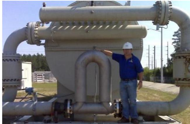
Figura 57. Medidor coriolis instalado en una línea de 10 in de diámetro nominal.
