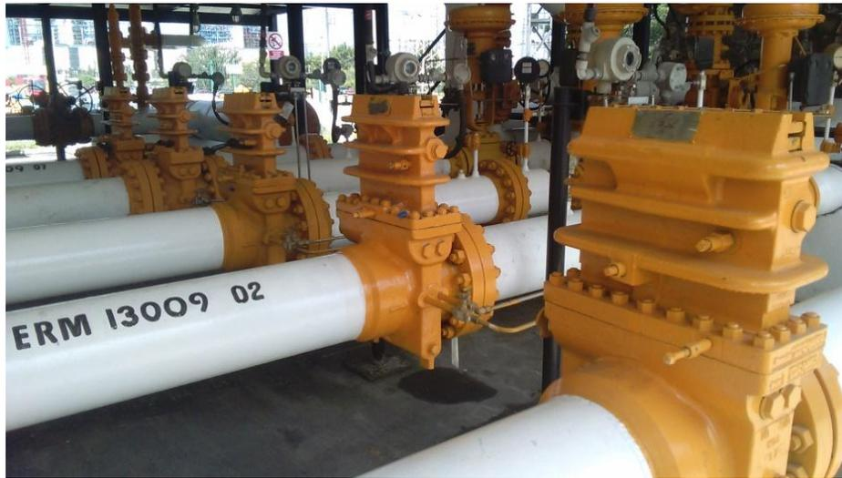
*Figura 19. Medidores de placa de orificio instalados en una estación de medición y regulación de una central de generación eléctrica de CFE.*
