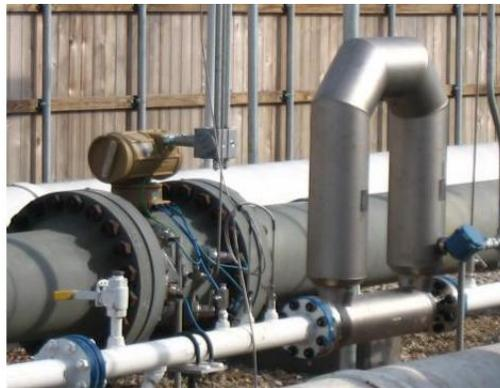
*Figura 58. Instalación de un medidor coriolis en una línea de 3 in y un medidor ultrasónico en una línea de 16 in.*
