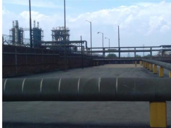
*Figura 90. Ducto de diámetro nominal de 12 in. por el que fluye el combustóleo de la Refinería Miguel Hidalgo a la estación de medición.*
