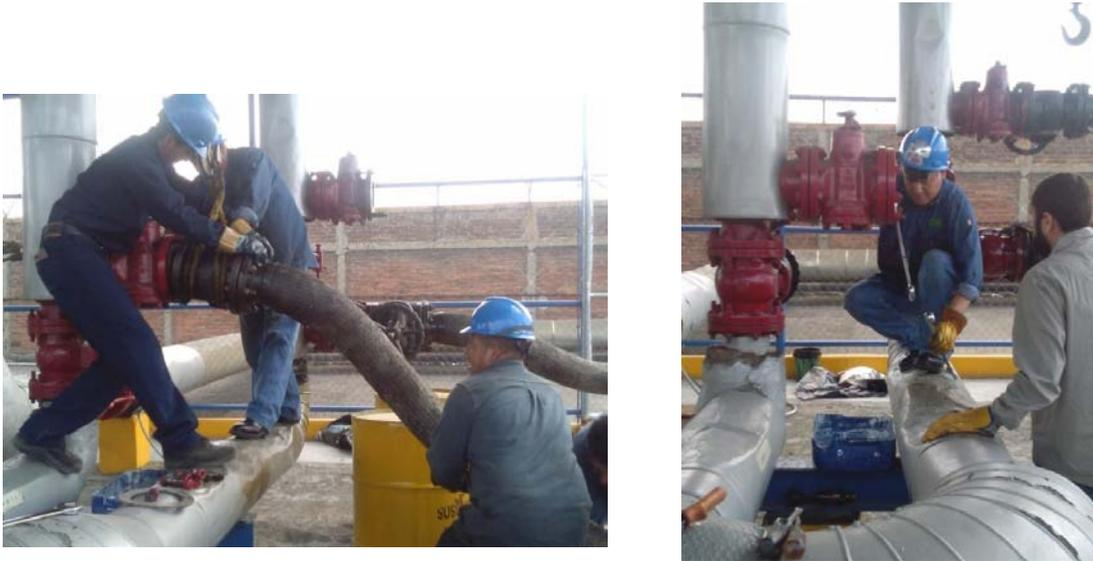
*Figura 94. Conexión de manguera a la válvula macho de la línea 1. En la imagen del lado izquierdo se observa la extracción de la brida ciega de la válvula macho por parte del personal de CFE y LAPEM.*
