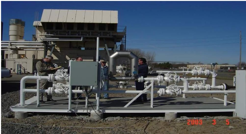
*Figura 107. Empleo de medidores tipo coriolis para medición de gas natural en una central de generación. Fuente: Micro Motion.*
