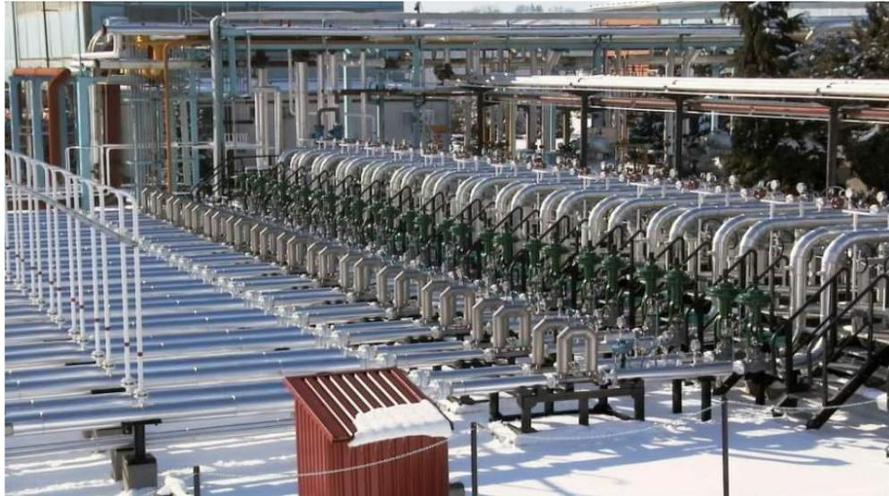
*Figura 106. Empleo de medidores de flujo másico en una terminal de almacenamiento de gas natural, Hungría. Fuente: Micro Motion.*
