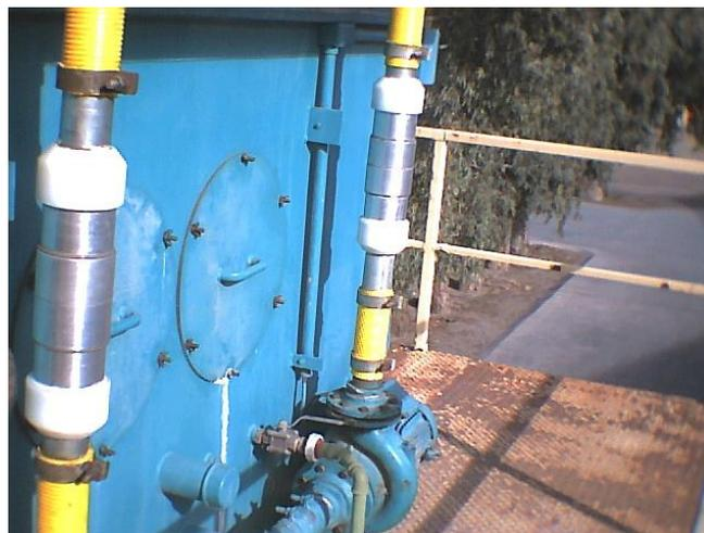
*Polarizador ECP (Semicelda electroquímica)*
