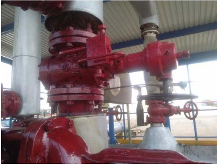
Figura 75. Válvula de doble sello instalado en la línea 2 de la estación de medición.
