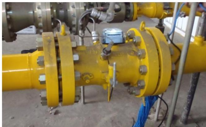
*Figura 26. Medidor tipo turbina instalado en la estación de medición de una central eléctrica.*
