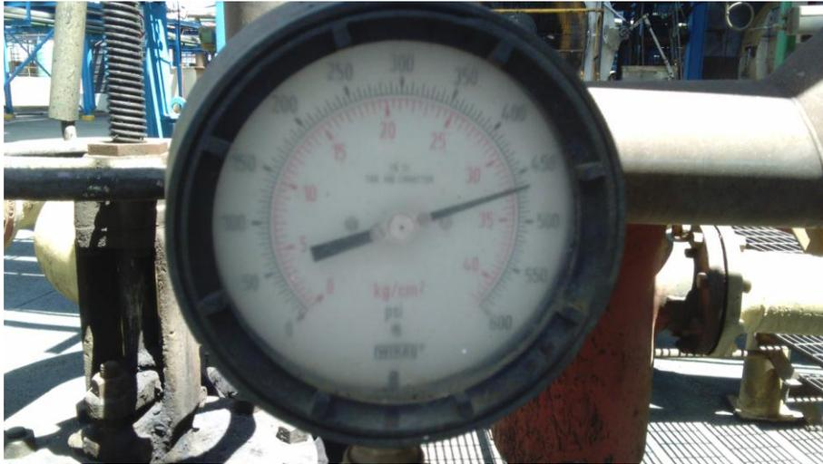
*Figura 105. Manómetro ubicado aguas arriba del medidor donde se lee una presión de 32.5 Kg/cm<sup>2</sup>.*
