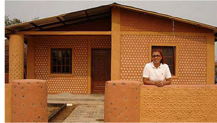
Casa construida con botellas de PET 126
