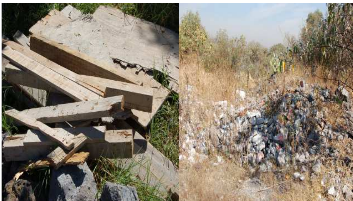
Figura 1.36. Desechos de obras y construcción dentro de la REPSA.
