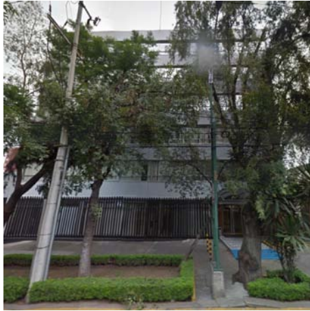
Figura 5.1. Primer caso de estudio (Edificio del SAE)
