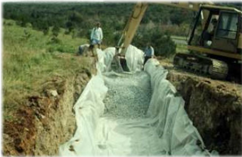
Figura 8. Ejemplo de una barrera de rocas calizas utilizada para el tratamiento del drenaje ácido de mina (Skousen, 2010).
